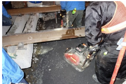
(d) プレートコンパクターによる転圧
