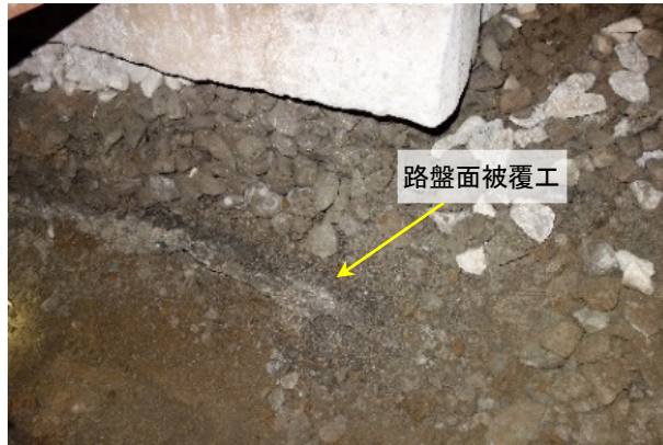
図4-19 路盤面被覆工（調査箇所1-2付近）
