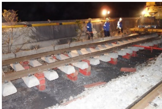
(e) サブバラスト層構築完了
