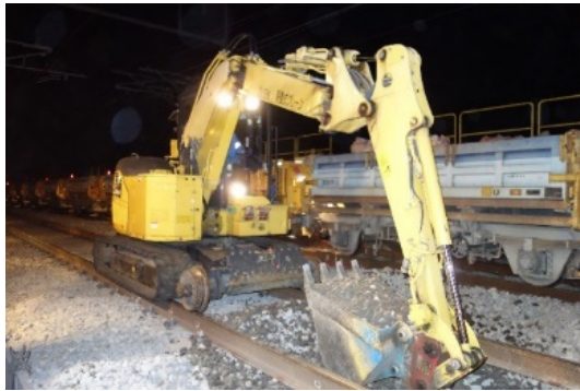
(a) バックホーによる掘削
