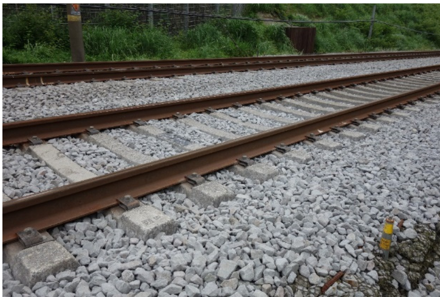
図1-3 東海道新幹線の土路盤区間における保守多投入箇所の例
