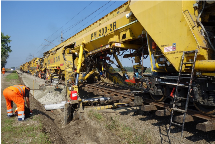
図6-8 大型保線機械による”Formation rehabilitation”の施工状況
