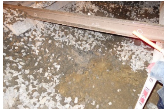
(b) 掘削直後の路盤表面
