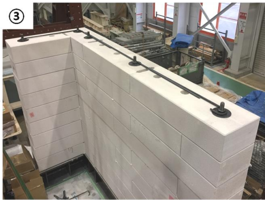
<縦筋および横筋の配筋>
