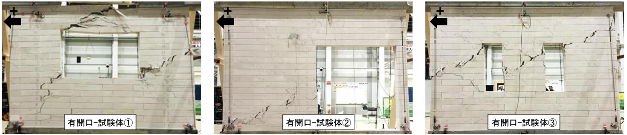
図 13 有開口組積壁の破壊状況（最大変形時）
