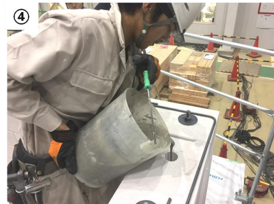
<グラウト打設>
