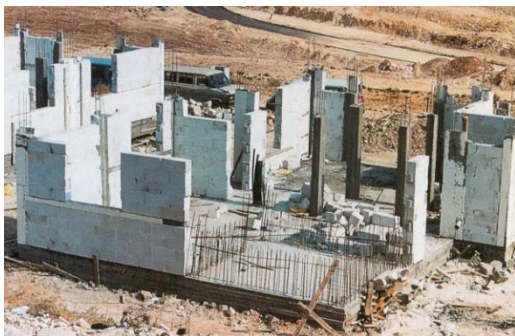
(d) RC フレームと ALC ブロックの併用 1.37)
