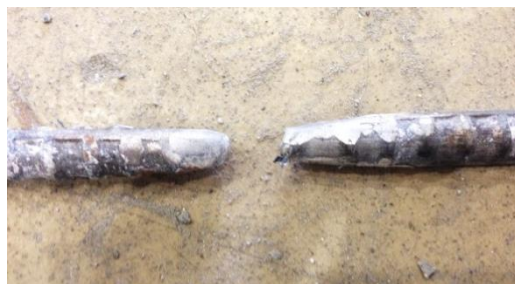
(f) 写真④ (破断した横筋)
