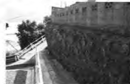
「崩れかけた擁壁」 地震により地盤が歪んだ擁壁。この上に住む住民からは安全な土地への引っ越しを検討しているとの声も聞かれた。
