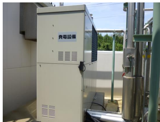
図 5-11 ガスエンジン発電設備 (2012. 8)
