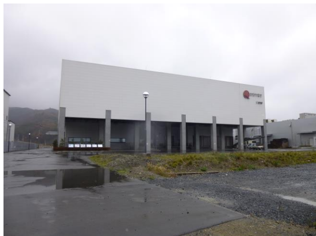
図 5-9 津波対策用冷凍冷蔵庫（女川、2015. 11）
