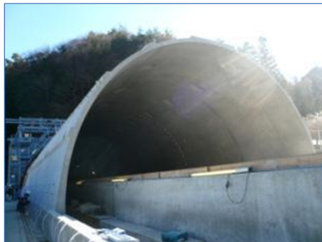
写真-6.4.2 改良型フードの断面
