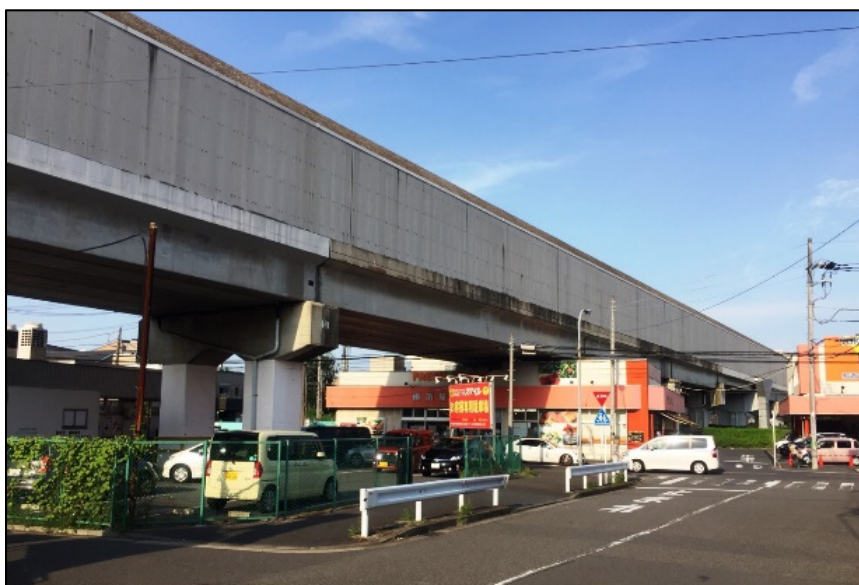
写真-2.1.1 東海道貨物別線の全覆防音対策(シェルター)
