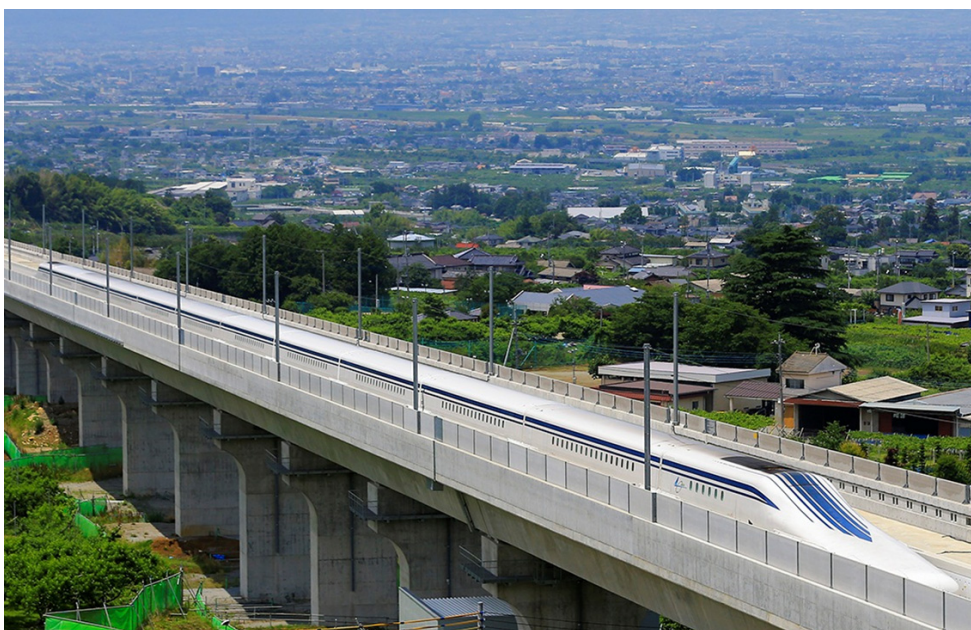
写真-1.1.1 超高速鉄道の施設及び車両
