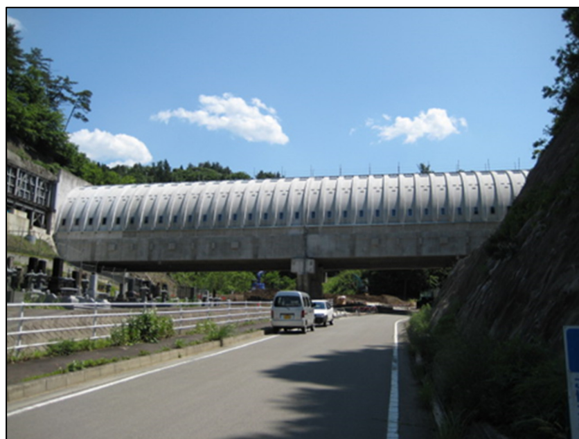
写真-4.3.1 試験用フードの設置状況
