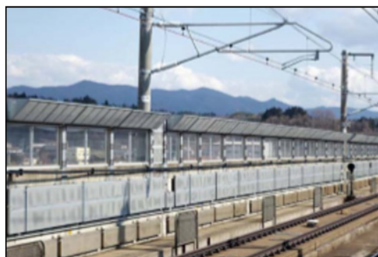
図-1.5.1.4 新幹線用騒音低減装置 49)
