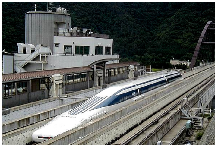
写真-1.3.2.1 車両空力特性改善のための試験車両
