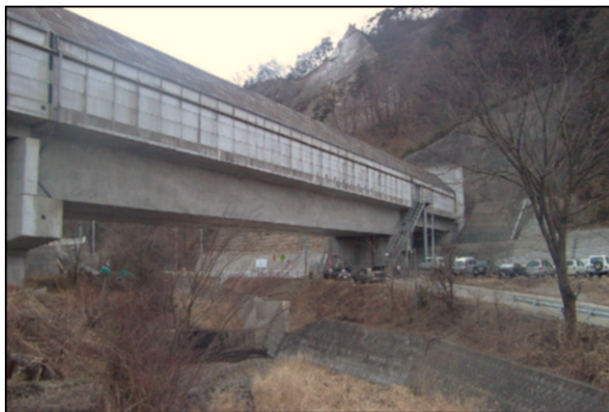
写真-2.1.2 山梨実験線の中間緩衝工
