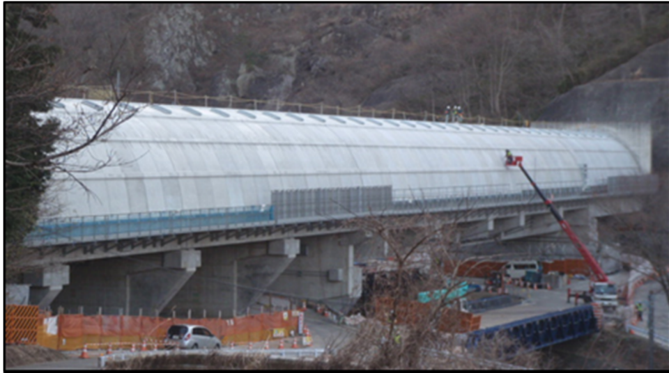
写真-6.4.1 改良型フードの概要
