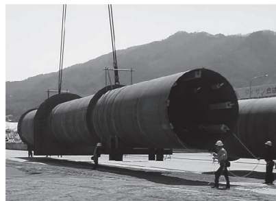
写真-4.1 通水管の施工状況と観測架台 (国土交通省東北地方整備局釜石港湾事務所提供)
