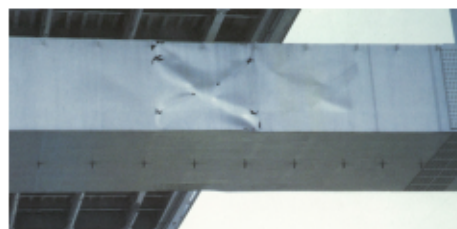
写真-付 2.1 2層構造鋼製ラーメン橋脚の下部水平梁に生じたせん断座屈の例 5)
