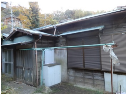
写真 3-2-5：28 番地区 空き棟継続・裸木造
