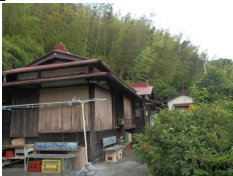
写真 3-2-7：17 番地区 空き棟化・裸木造
