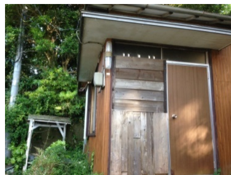
写真 3-2-6：28 番地区空き棟化・トタン
