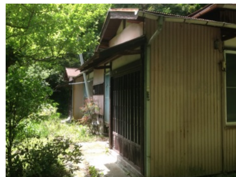
写真 3-2-8：17 番地区 空き棟継続・トタン
