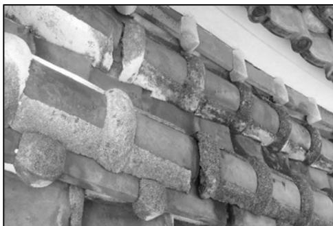
写真21 屋根漆喰破損状況
