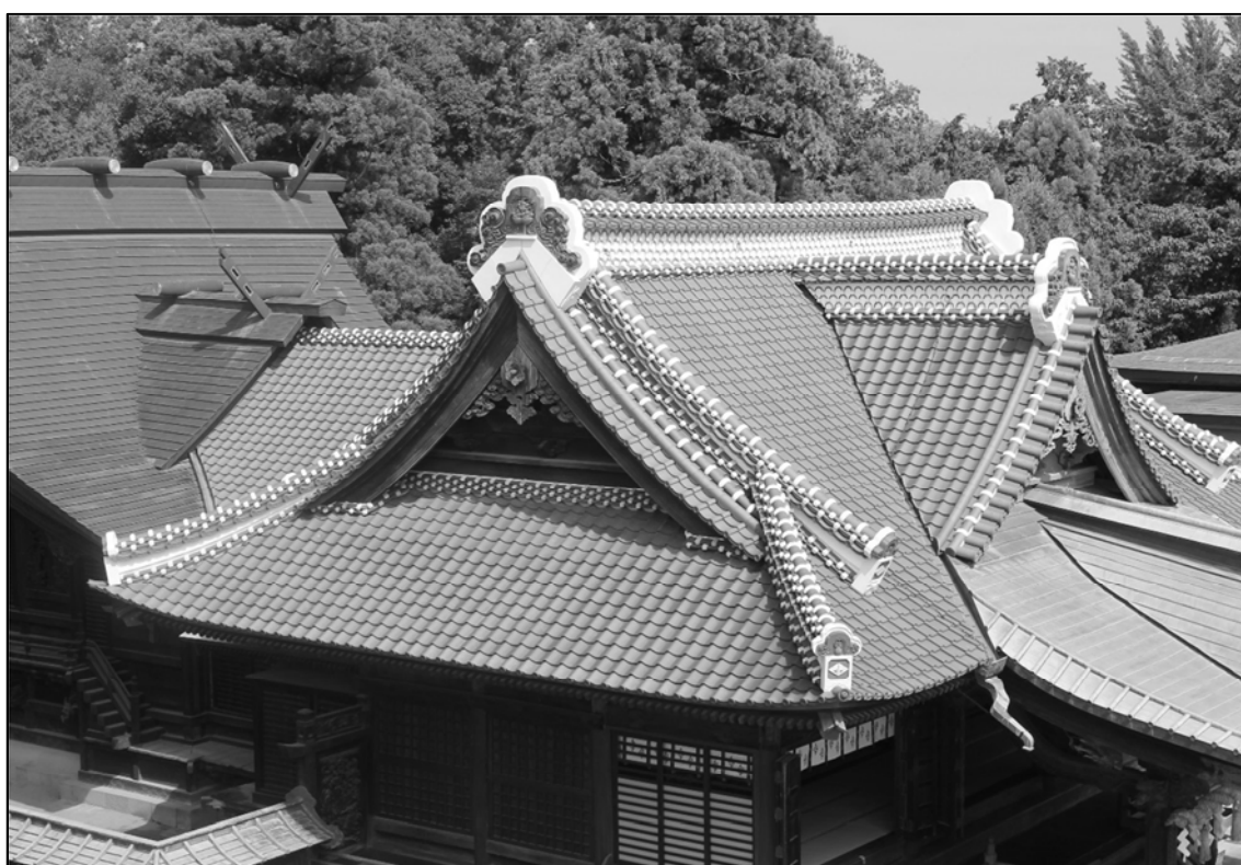
写真 33 箭弓稻荷神社拝殿・幣殿屋根に載る白色紐付き燻し和瓦（竣工時）
