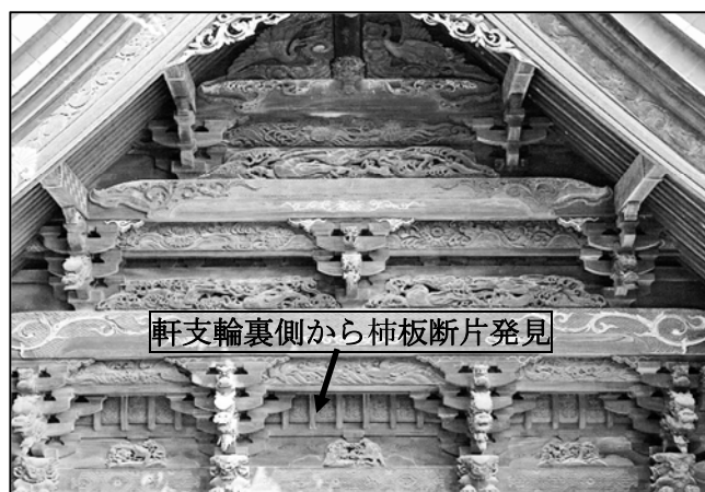
写真 5 本殿屋根蟻羽軒支輪小屋裏側からの発見当初屋根材
