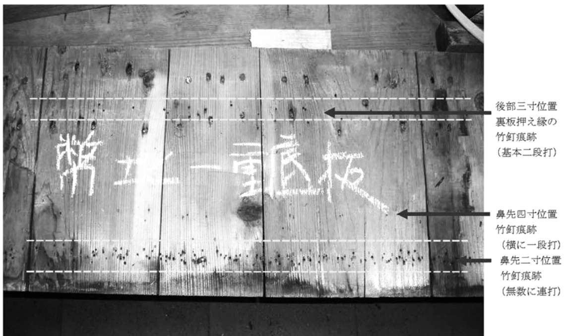
写真 7 幣殿裏板上に残る竹釘孔痕跡状況
