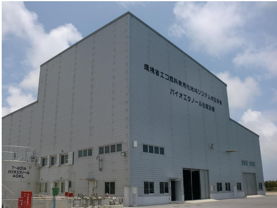
付録-写真 9 バイオエタノールプラントの外観 (2011年6月筆者作成)
