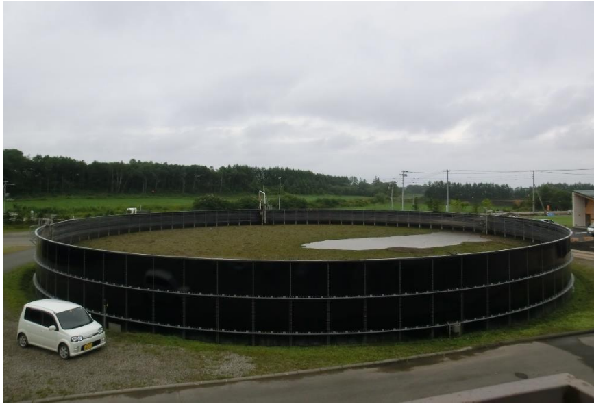
付録-写真 7 消化液貯留槽 (2013年9月に筆者撮影)
