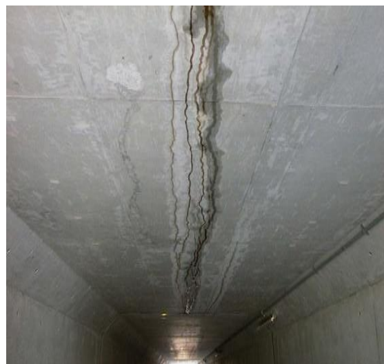
(d) Box culvert
