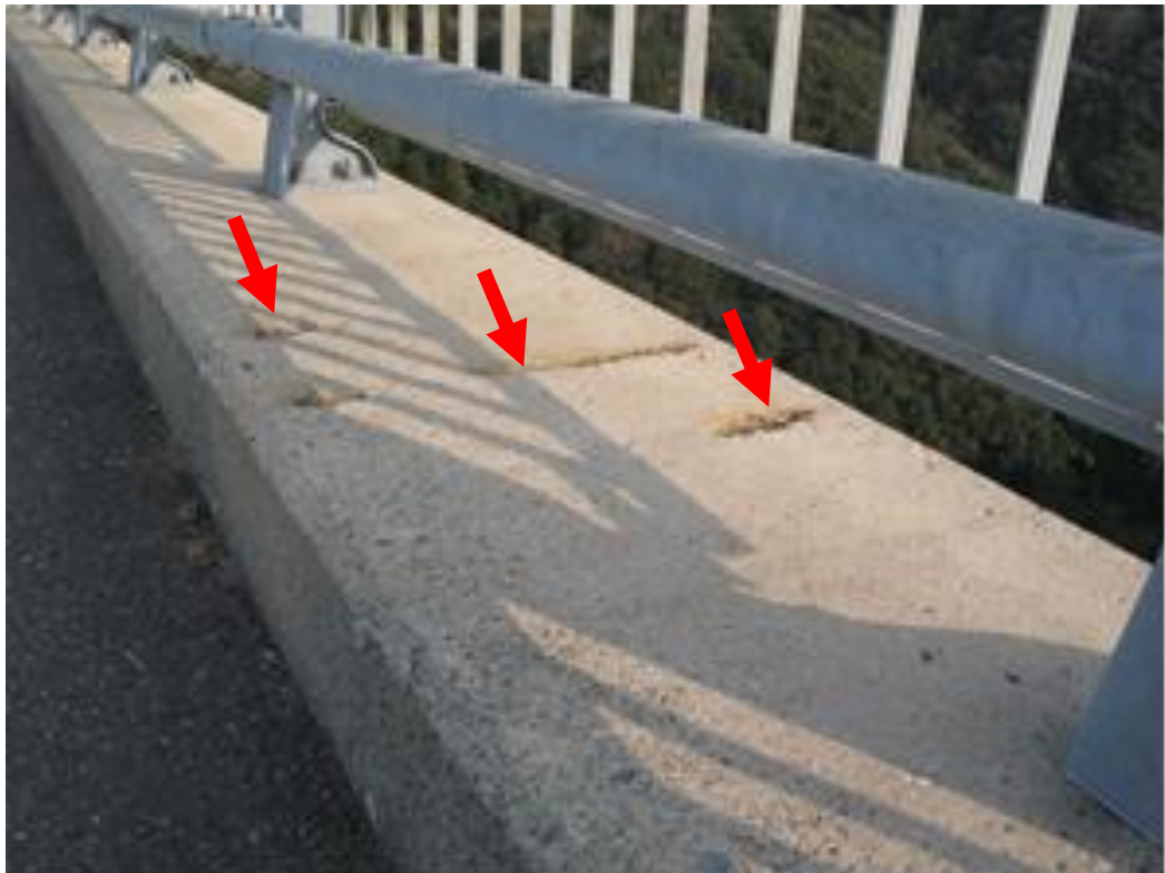
写真-1.1.13 橋梁地覆における鉄筋腐食（天端）
