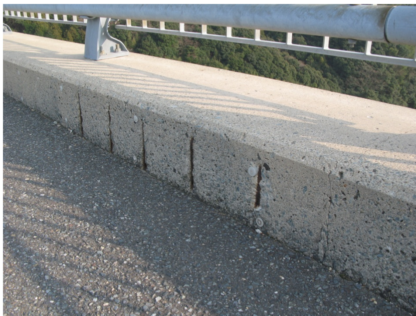
写真-4.3.1 かぶり不足による鉄筋腐食の事例（側面部）
