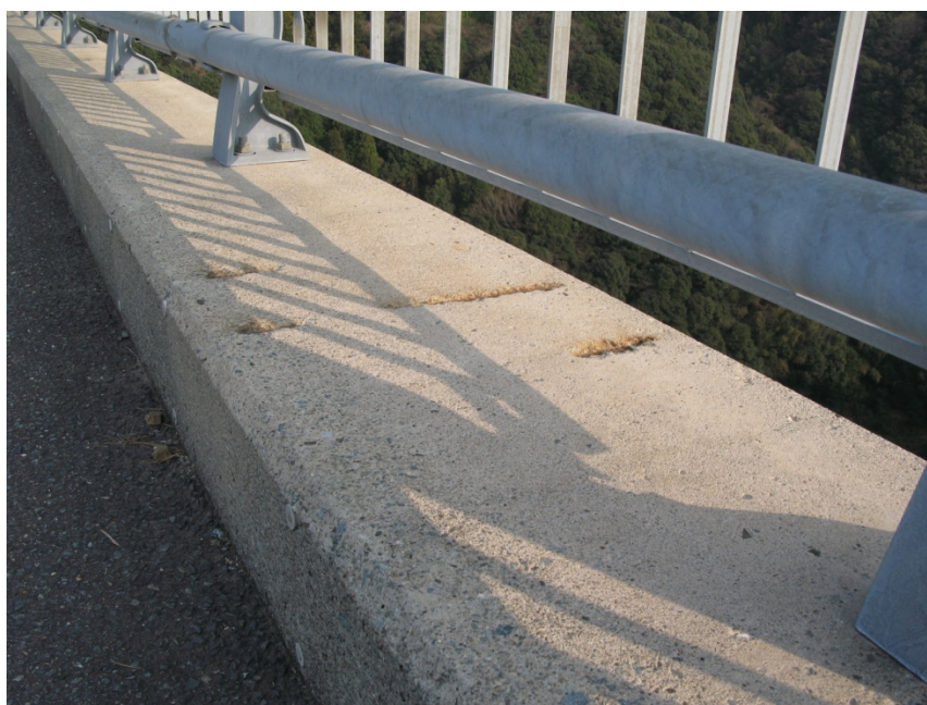
写真-4.3.2 かぶり不足による鉄筋腐食の事例（天端部）
