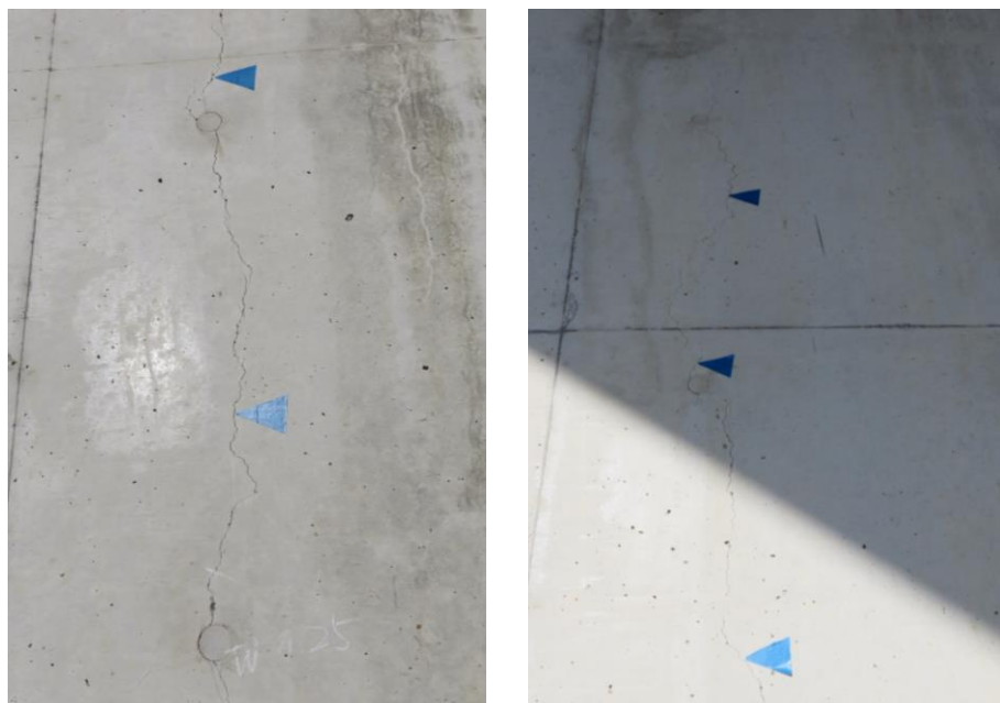
写真-1.1.3 鉛直方向のひび割れ
