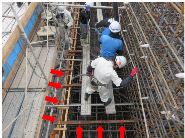
写真-3.12.2 橋台たて壁の施工事例
