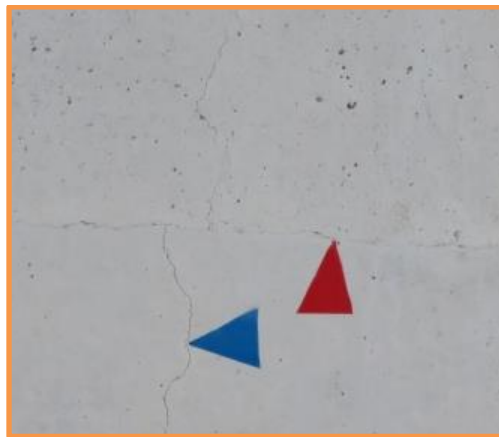
写真-1.1.7 打重ね線沿いのひび割れ部の拡大
