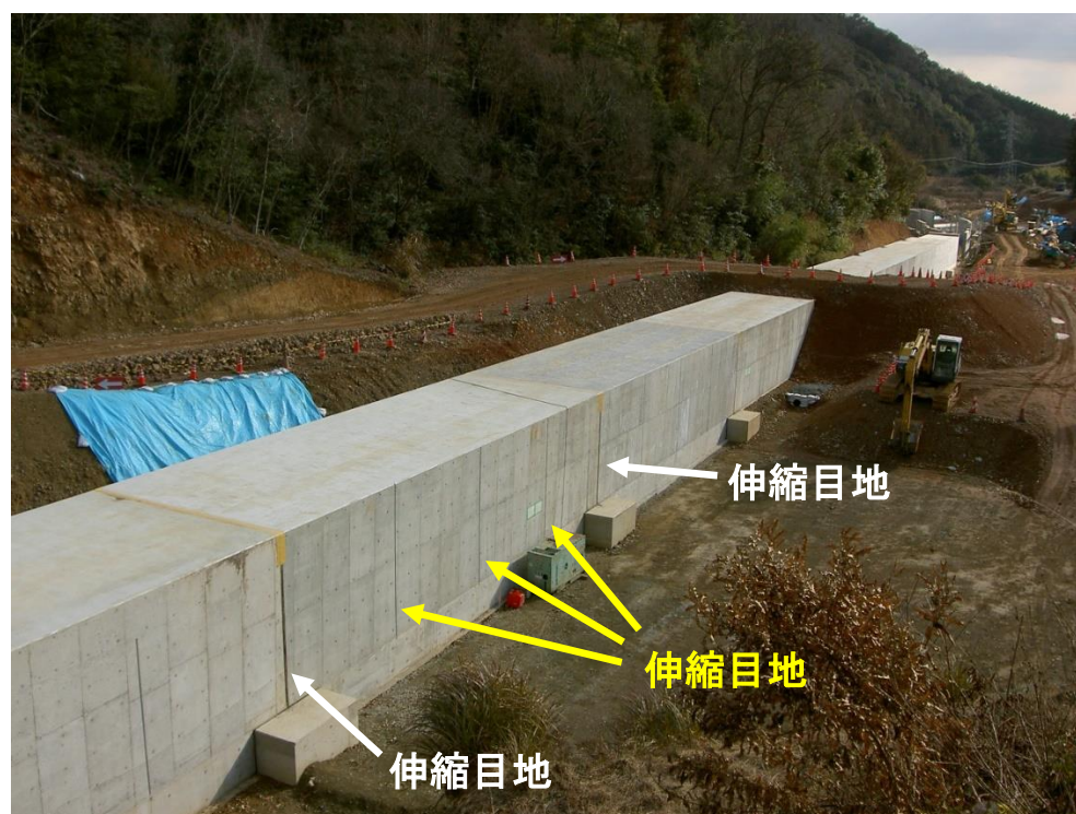
写真-2.3.1 北山田2号水路函渠（長さ248m 17ブロック）
