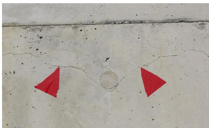
写真-1.1.4 セパレータコーン付近の沈みひび割れ
