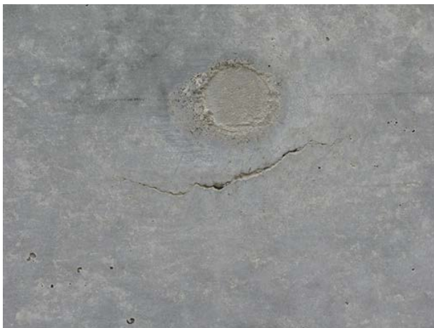
写真-4.5.3 既設橋脚の沈みひび割れ
