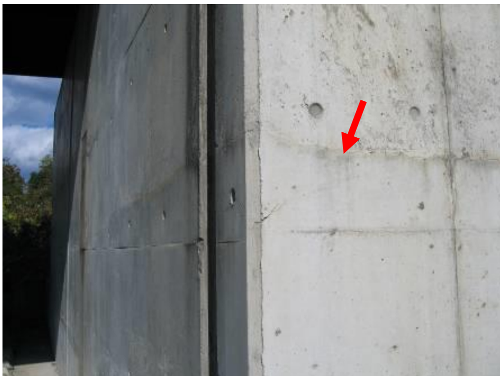
写真-1.1.9 逆 T 式橋台たて壁におけるコールドジョイント
