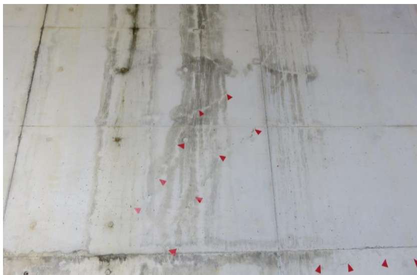
写真-1.1.8 斜め方向のひび割れ
