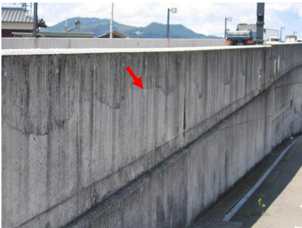
写真-1.1.11 剛性防護柵（壁高欄）における波型の打重ね線
