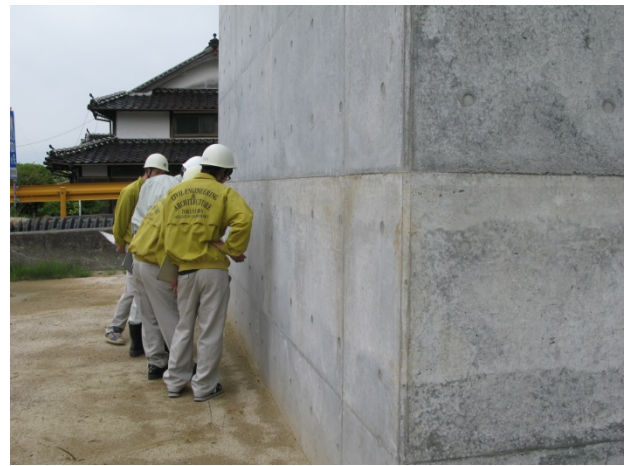
写真-4.5.4 既設橋脚の打重ね線
