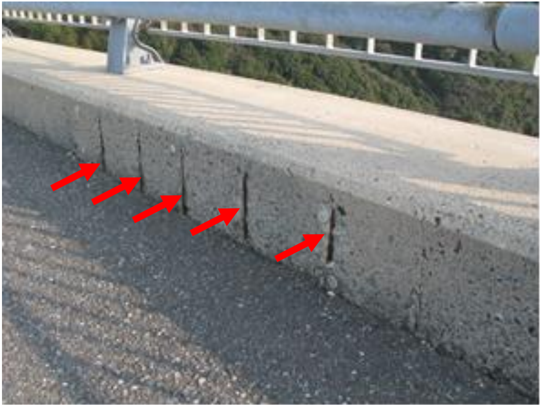
写真-1.1.13 橋梁地覆における鉄筋腐食（側面）
