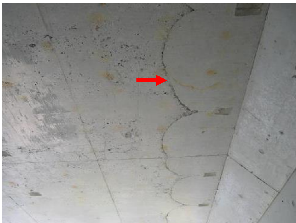
写真-1.1.10 ラーメン式橋台頂版部におけるコールドジョイント
