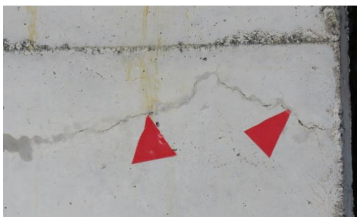
写真-1.1.5 隅角部の沈みひび割れ
