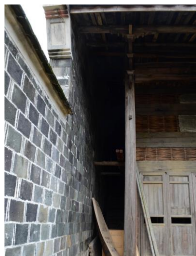
図 3.35 「空斗」レンガ防火壁と真壁の二重壁構造
