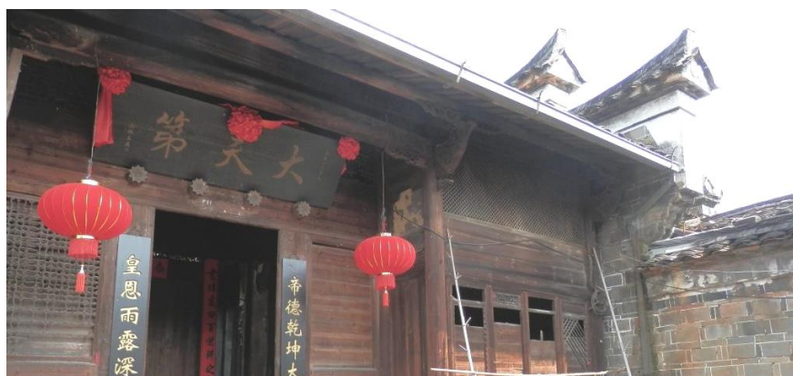
図 3.65 閩北「牛腿」変形と「壻頭」の併用（武夷山下梅鄒邸）
