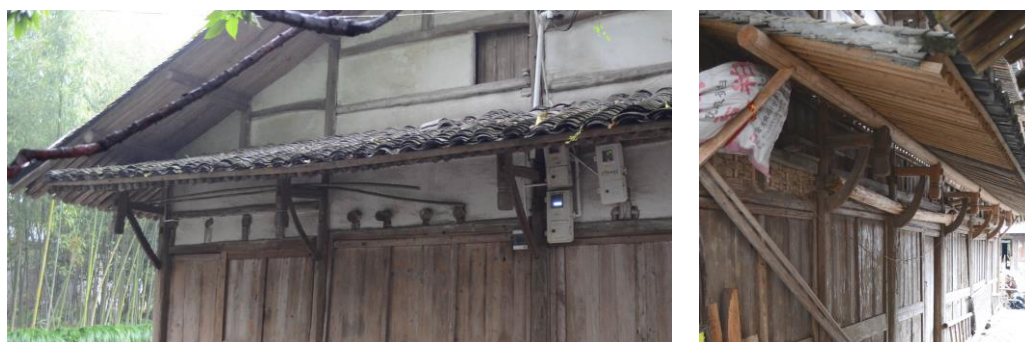
図 3.38 「垂花柱」と方杖の混合的作法（左は騰蛟、右は青街）
