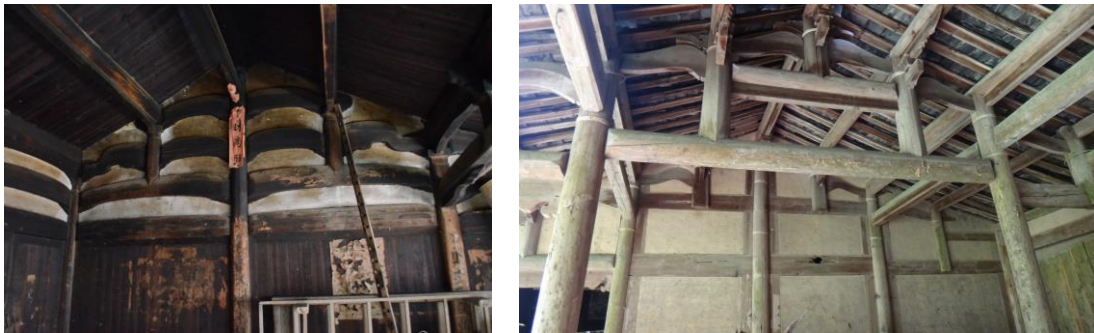
図 3.4 挿梁構造
