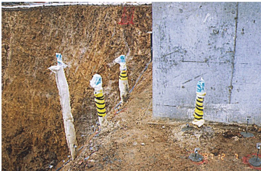
(2)地中変位計測用のケーシングの設置状況
