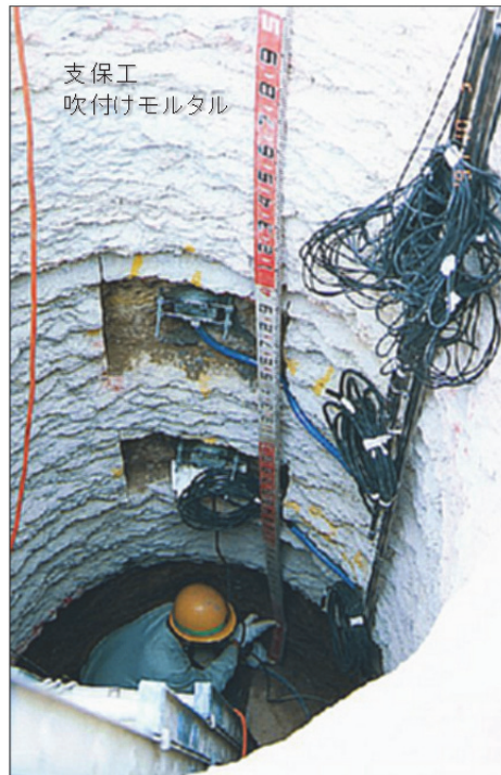
図 4.16 土圧計の設置状況
