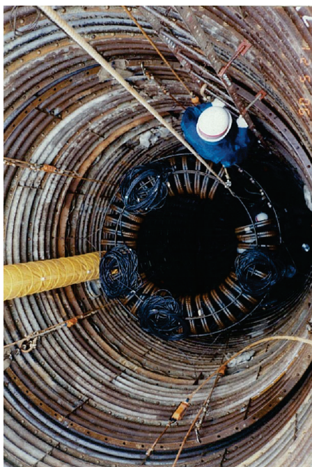
図 2.1 深礎基礎の掘削と躯体部の配筋の施工状況
