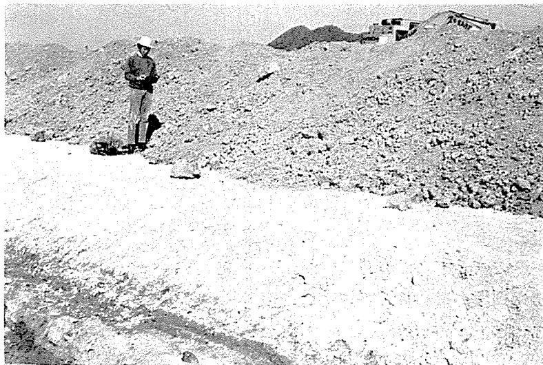
Phot. 18. 香椎浜地区の基礎作り。表層土を還元して本格的環境保全林の創造が望まれる。Der Zustand des Landes, das durch Zuschütten aus dem Meer gewonnen worden ist; hier sollte auf den mit Mutterboden überdeckten Dämmen ein neuer Umweltschutzwald aufgebaut werden (Kashihama).
