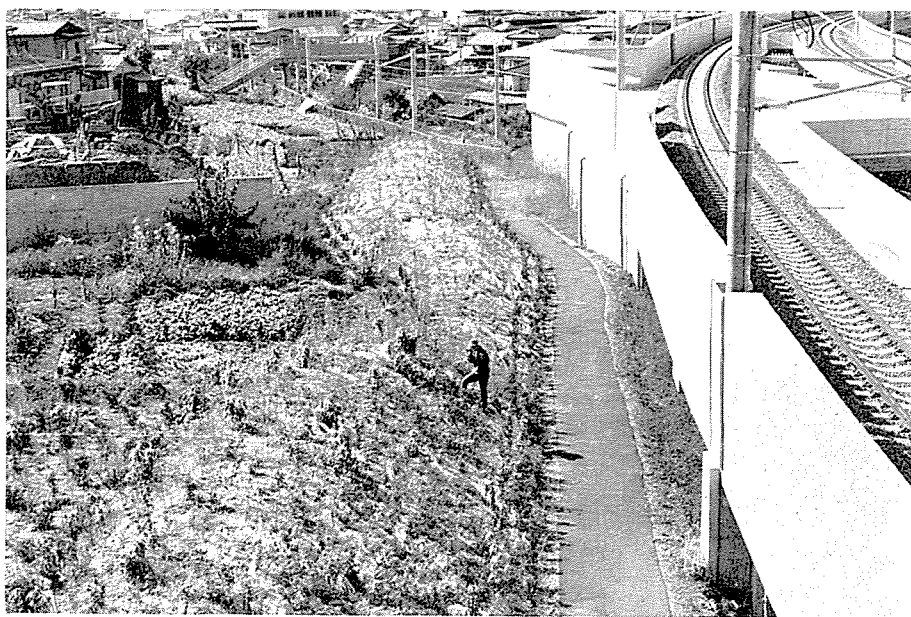
Fig. 32 岡谷E地区の生育状況（植付後約3ヶ月目，1982年10月25日） Zustand des E-Bezirks in Okaya (3 Monate nach der Bepflanzung, 25. Okt. 1982).
