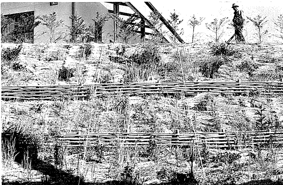
Fig. 4 竹材による斜面保持の実施例（三沢，R地区） Entlang der neuen Bahnlinie wurde ein Damm, aufgeschüttet und mit den Bambusrohr oberflächlich geschützt; darauf wurden Jangbäume gepflanzt (Misawa, R-Bezierk).
