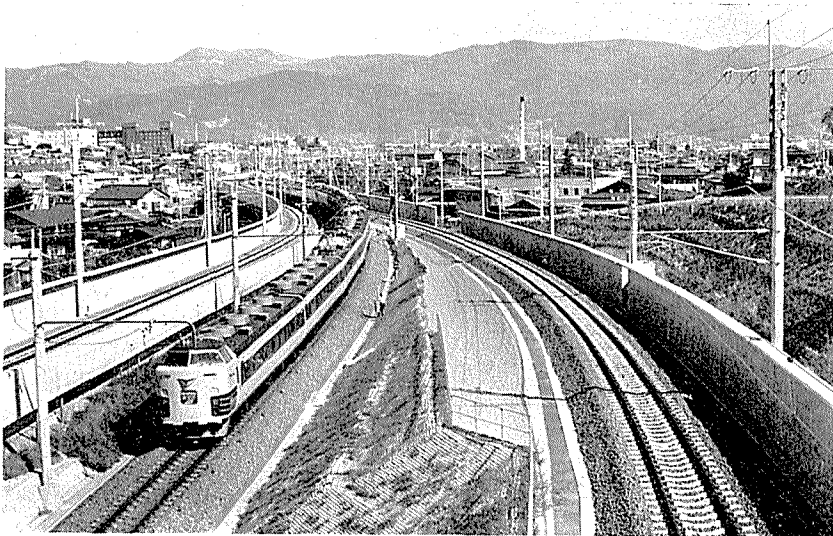
Fig. 2 岡谷市街地内を通過する中央本線の新線 Neue Eisenlinie von JNR, die in der Stadt Okaya durchziehend (900m ü. NN).
