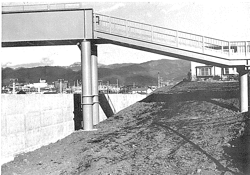
Fig. 25 鉄道環境保全林形成予定地，歩道橋付近
