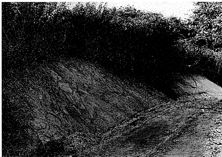
Photo. 12 潜在自然植生がシラカン群集典型亜群集域の土壤断面。ローム層は数mにもおよぶ。
