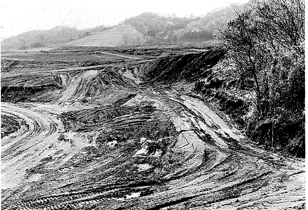
Fig. 63. 植生と表土をすべてはぎとってしまった大規模造成地。環境改善の必要性から大きなツケがまわってくる（高松山，標高100 m付近）。
