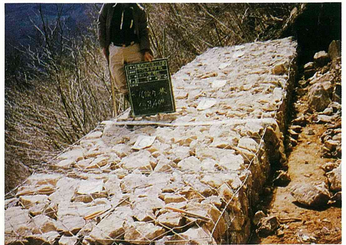
Photo. 3 フトン籠工法による基礎安定(十日沢1号)
