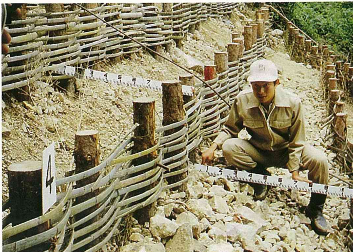
Photo. 4 竹柵工法による基礎安定(十日沢1号)
