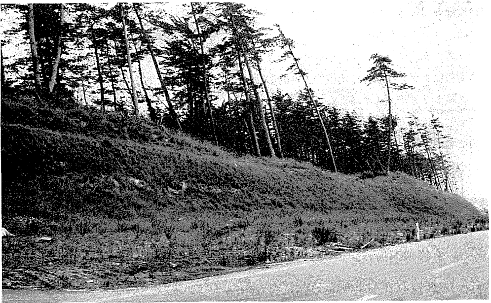
Fig. 28 のり面吹きつけに外来牧草を使ったが、その後不安定で好ましくない例（酒田市北港）。
