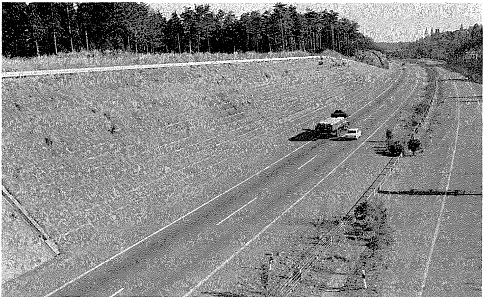
Abb. 49 成田と首都を結ぶ高速道路（東関東自動車道路）。 外来牧草で緑化された斜面（荒立橋）。
