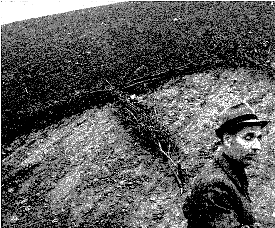
Phot. 98 アウトバーンぞい斜面の植栽予定地に盛土された表層土 (西ドイツ, ドルトムント付近)。Wiederherstellung des Mutterbodens vor Neu-Pflanzung an der Autobahn bei Dortmund, (Bundesrepublik Deutschland) sicher durchzuführen. Phot. Aufn. Sep. 1974 mit Herrn Fritz Tüxen.
