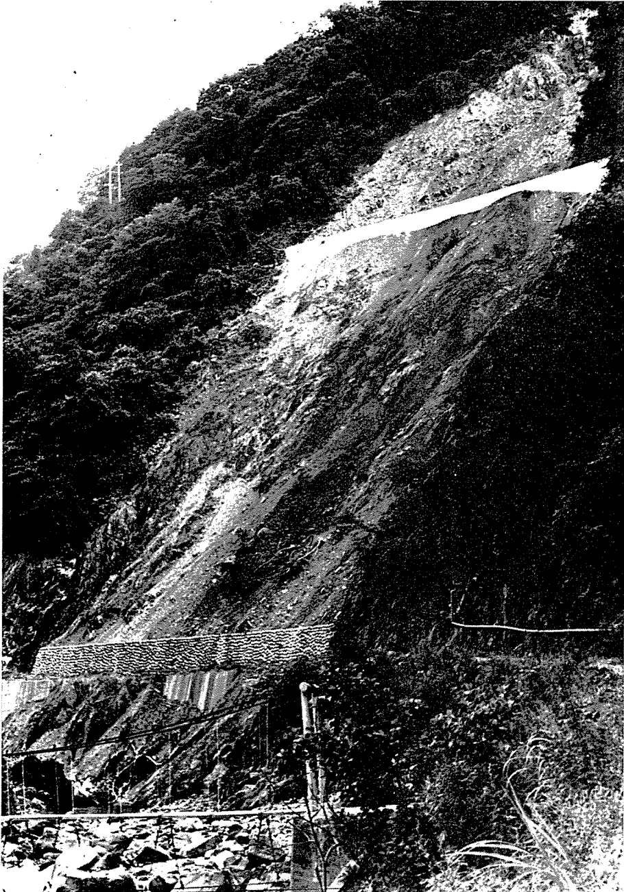
Phot. 109 道路工事により消失した緑の面がひきがねとなり、ひきおこされた崩壊 (丹沢)。 Durch Vernichtung der standortgemäßen natürlichen Wälder verursachter Bergrutsch (Berg Tanzawa).
