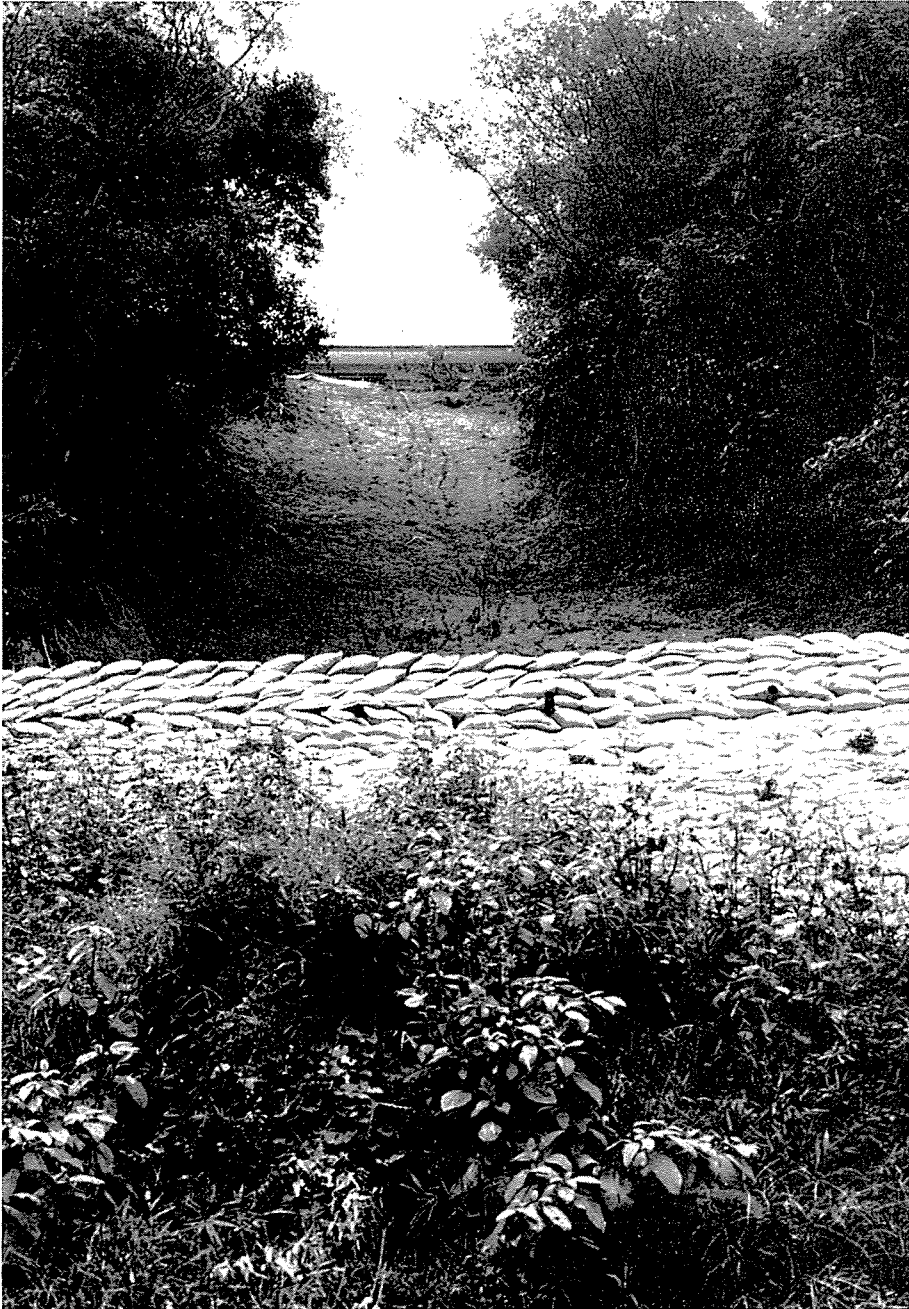
Phot. 44 豪雨のたびに土砂崩れが起こる危険な造成地。両側に残存するのは、オニツバリーコナラ群集 (横須賀)。
