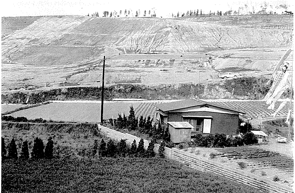
Phot. 54 新しい造成地では全てが切りくずされ、つくりなおされている。降水時の土砂崩壊を招きやすい。
