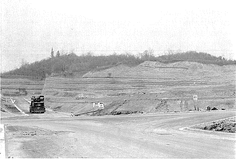
Fig. 10 丘陵地で進められる大規模な宅地造成は緑の植被をすべてはぎとり、原地形を大きく変容させながら進行する（多摩区）。
