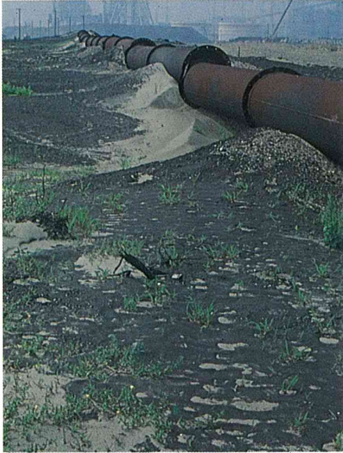
Bild 5. サンドポンプによる埋立地。 Neuen Landgewinnungs-Zustand vom Meer mit der Sandpumpe.
