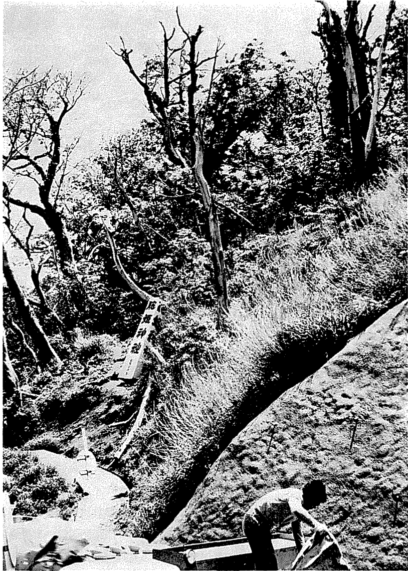
Fig. 18 胞姫神社国道沿いはコンクリート吹きつけが行われ、高木が枯死しているのが目につく。
