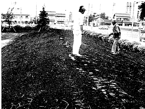
Fig. 43. 表層土をのせたマウンド形成。
