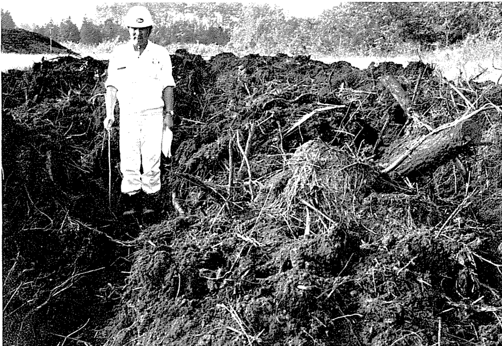
Fig. 119. 表層土の掘り返し。
