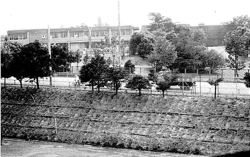
Fig. 89. 斜面保全, 環境保全林を目指して急傾斜のり面に植栽された シラカシのポット苗 (和光研究所)。
