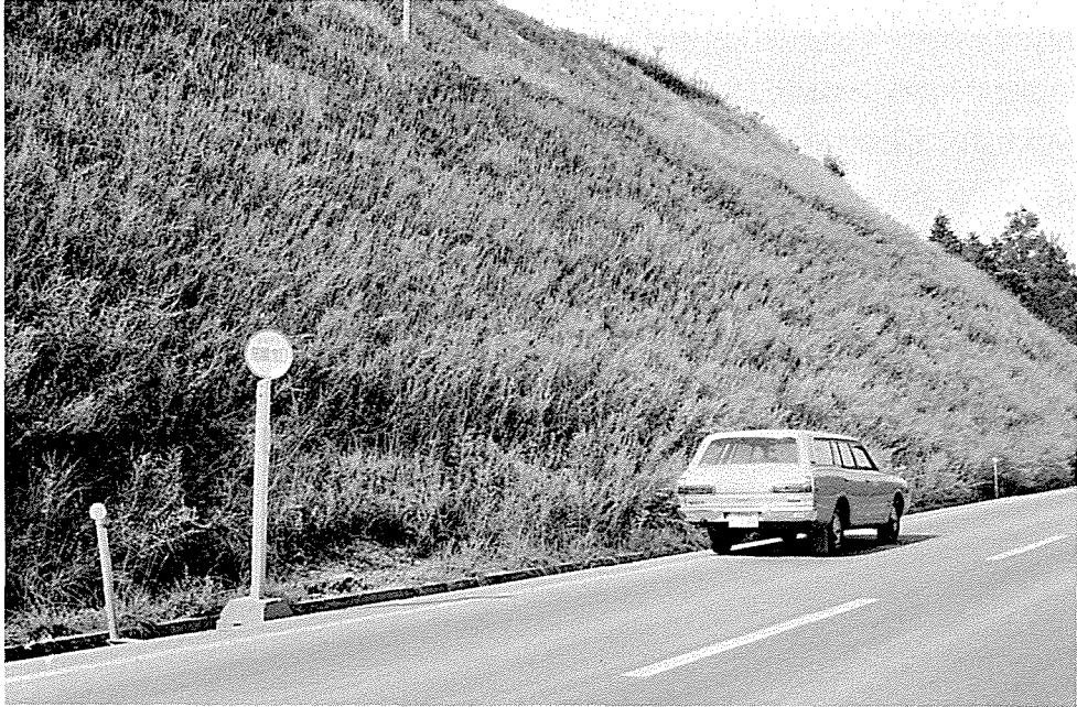
Phot. 57 道路のり面にふきつけされた外来種のヨモギ類。期待通りにススキ、トダンバ、チガヤなどが侵入し、安定することによる、森林化への道は遠い。すでに2年目の調査では裸地化しているところも見られた。
