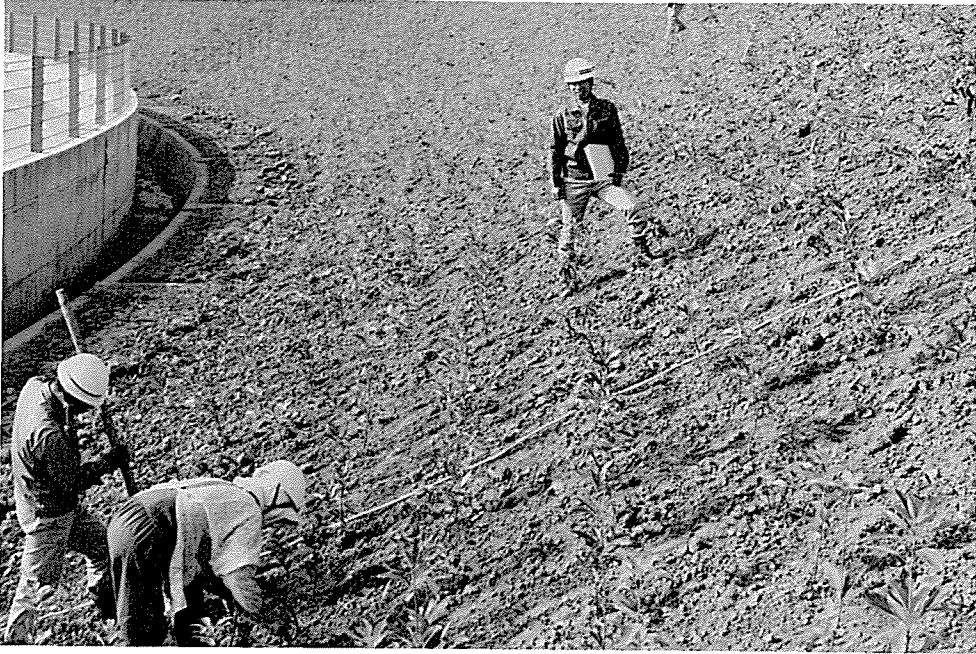
Phot. 52 植栽完了時の土捨場 (1978 年 11 月)。
