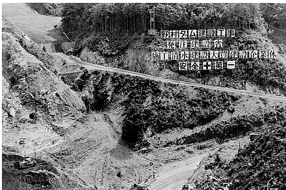
Phot. 1 野村ダムのダムサイトの造成地。 Baustelle des Staudamms von Nomura.
