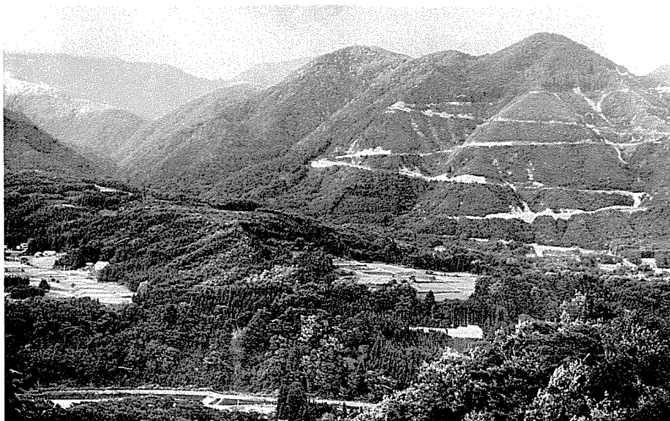
Fig. 33 塩那道路塩原側の眺望。白くむき出された山肌は景観要素としてもマイナスである。
