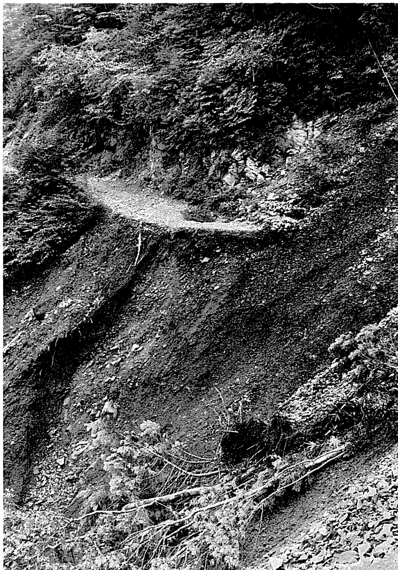
Fig. 34 台風により寸断された塩那道路（海拔 1,200 m）。 Durch Taifun Streckenweise zerstörte Enna-Bergstraße (1,200 m ü. NN).
