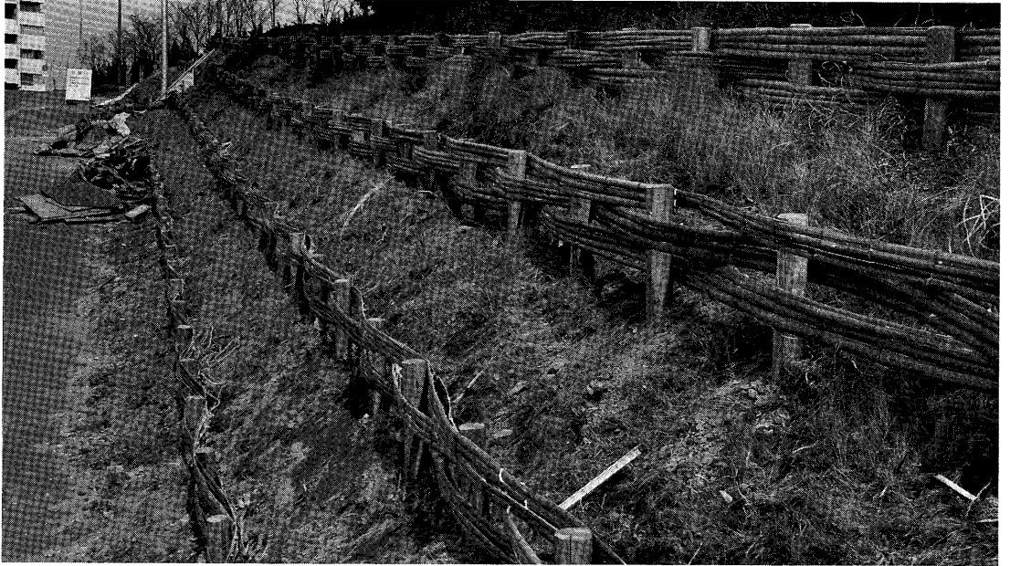
Figure 23. 潜在自然植生を基礎とした環境保全林形成ノウハウ例1。横浜国立大学正門付近の通学道路沿い斜面に形成した例。かつては外来牧草が播種され、荒廃していた幅2~3m, 45°以下の斜面に竹や粗朶で土留めのしがらを組む(1979年5月)。
