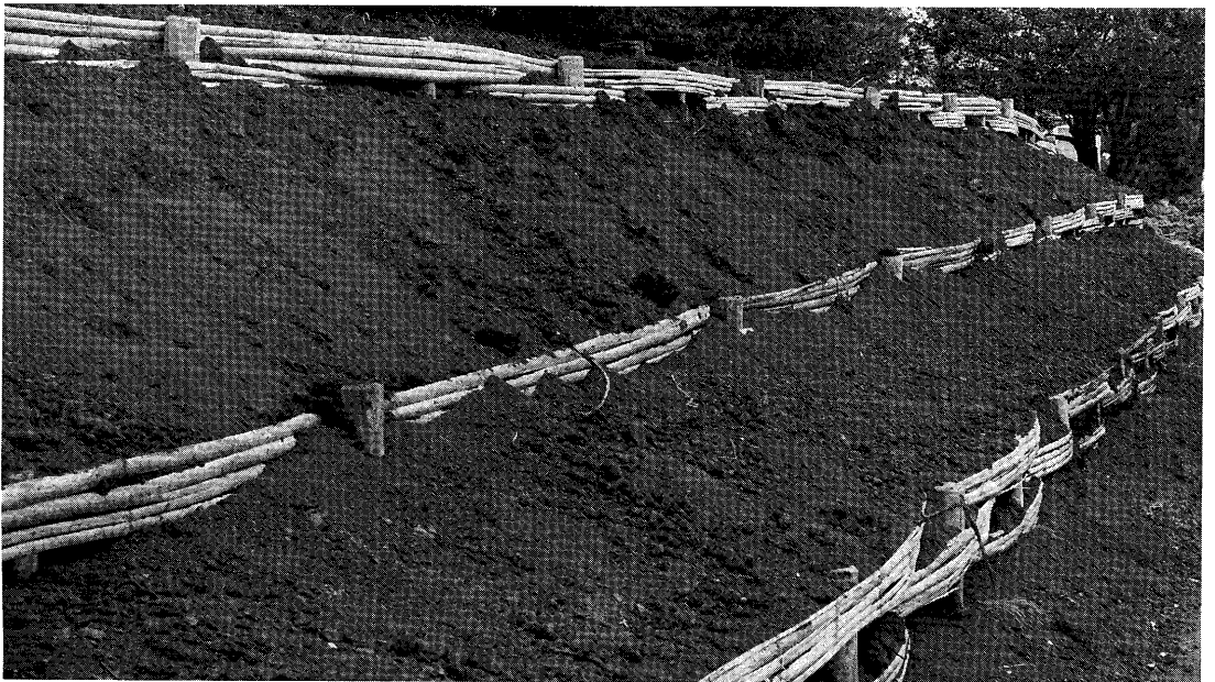
Figure 24. 表土を掘り出した後に20~30cm 客土をする。 The topsoil is applied to the slope to a thickness of 20-30cm.
