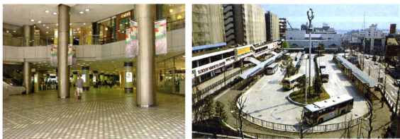
図6-3 駅と商業施設の一体的空間（左）と再整備された駅前広場（右）
