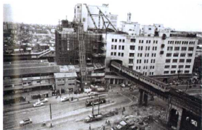
図3-5 渋谷駅での駅ビル整備
