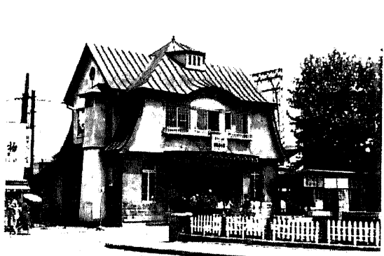
図3-2 田園調布駅西口本屋
