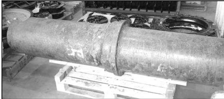
Fig. 5-1 100年間以上使用された横浜市創設水道管の外観
