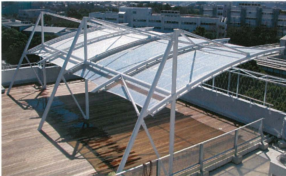
図 4.1 延伸成形によるテンションタイプの適用事例
