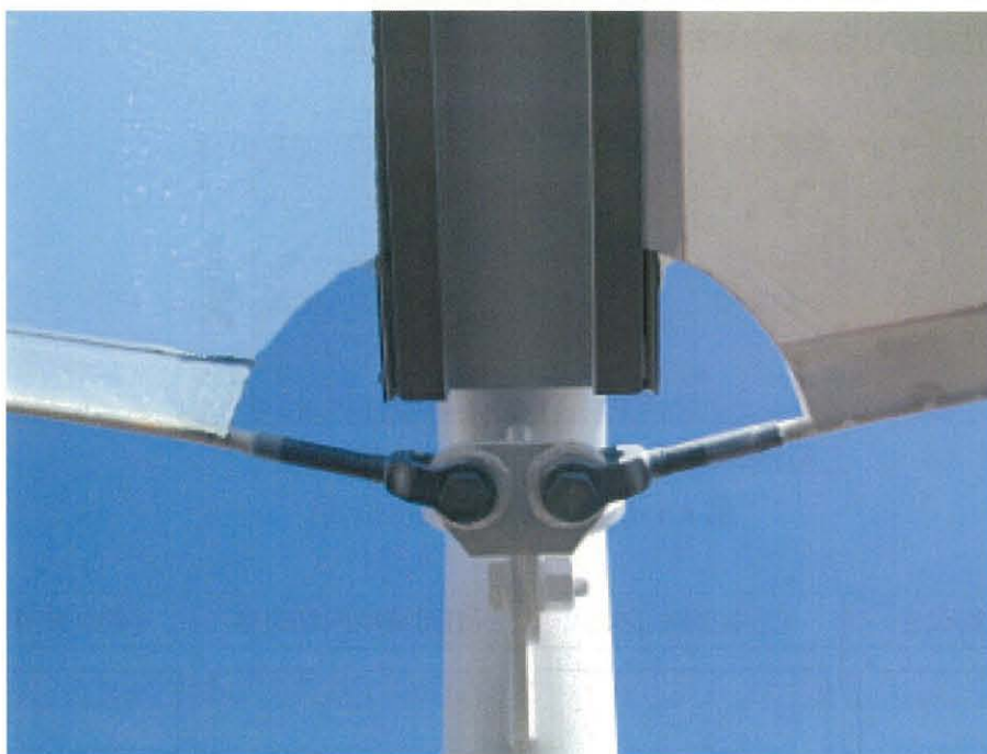
図 4.2 応力集中部のコーナー処理
