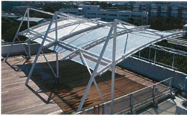
(b) 建築学棟屋上シェルター(テンション方式、横国大、2009)
