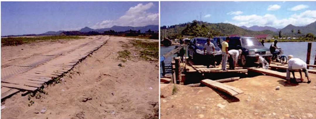
写真 3-6 復旧が進まない西海岸道路の状況（2008年8月撮影）
