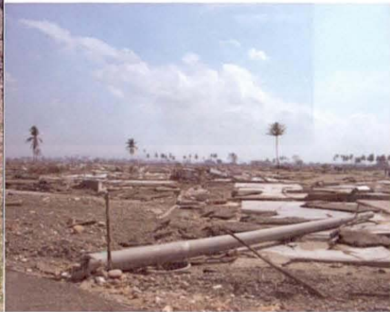
(2005年1月著者撮影、写真3-3、写真3-4とも) 写真 3-2 ウレレ地区（海岸直近）被災状況
