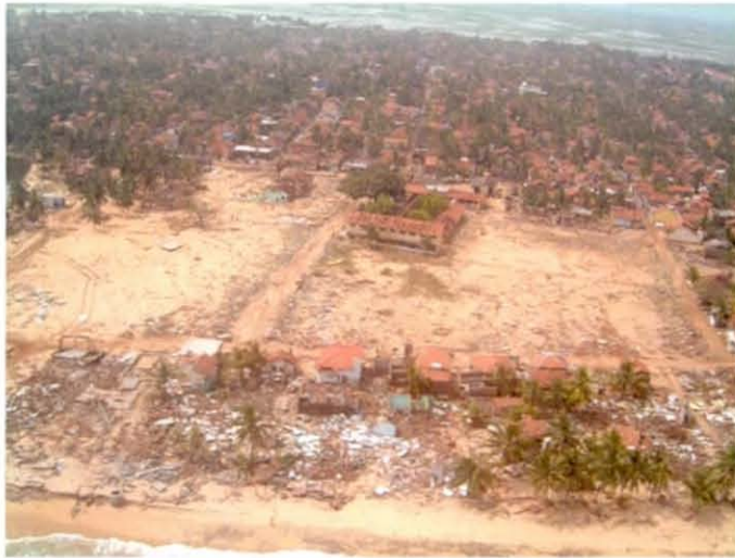
写真 3-8 東部地区の被災状況 (JICA 提供)
