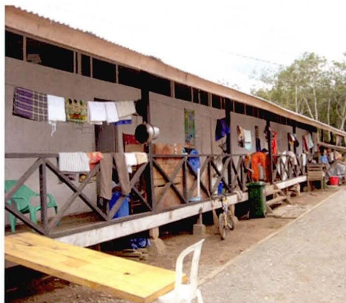
写真 5-4 PU 標準の仮設住宅：Alpen（アルペン）（2008年8月撮影）
