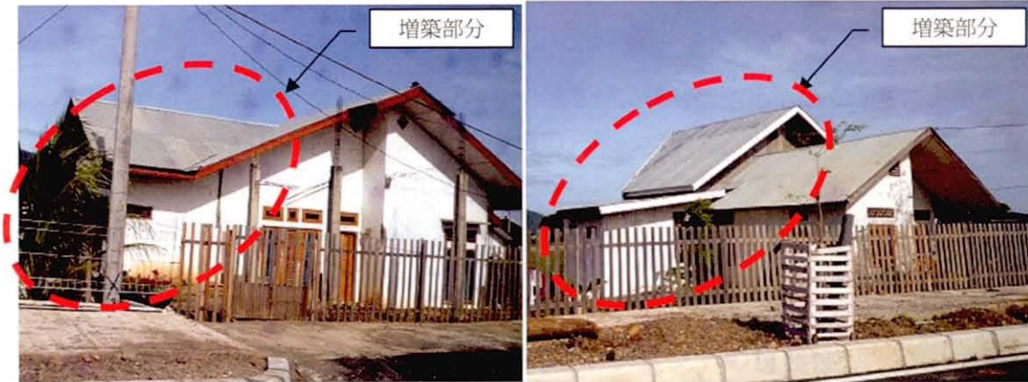
写真 7-1 増築された恒久住宅 (2009 年 8 月)
