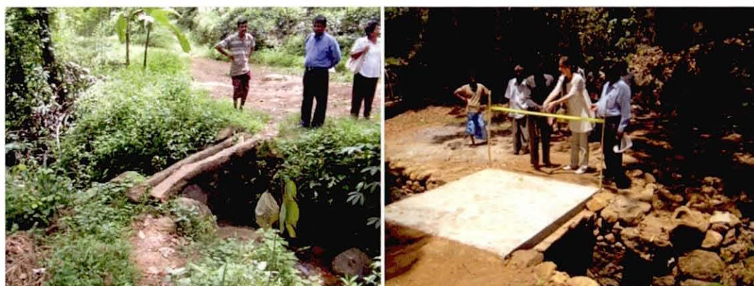
写真 4-2 避難路となる橋の改修（コミュニティの発案に対し JICA が資金提供）
