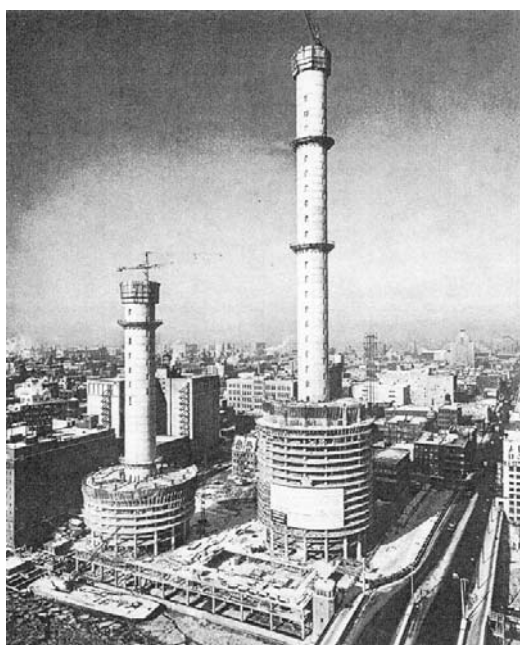
写真 1.1-2 施工中のマリナシティ 2)
