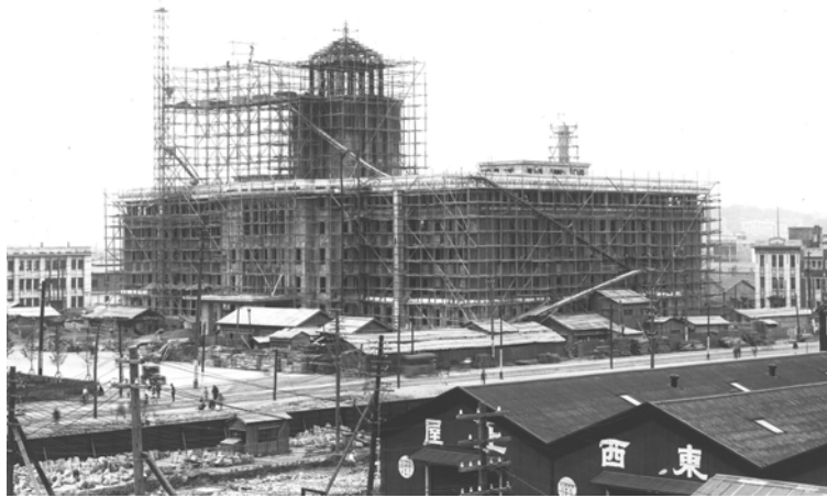
図 2 - 6 0 正面玄関側から撮影したもの、トラックの形が時代を感じさせる。
