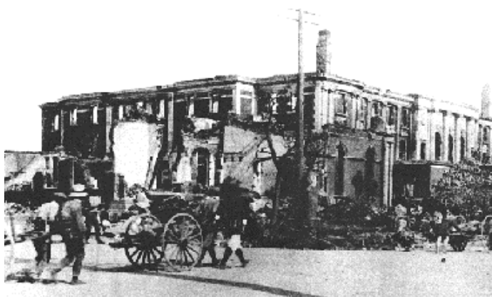
図1 - 4 5 県庁被災写真
