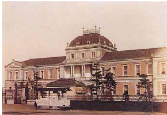
図1 - 2 5 辰野金吾設計の明治23年に建設された横浜地方裁判所
