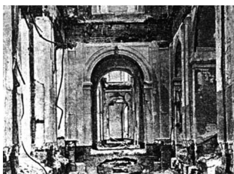
図1 - 4 6 被災後の県庁内部
