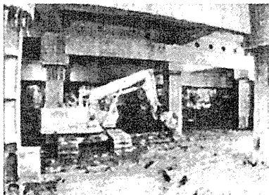
②掘削工事にてバックホウで引き倒す
