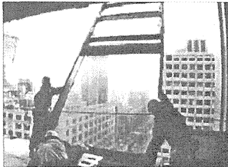
工場製作パネルによる現場加工の削減
