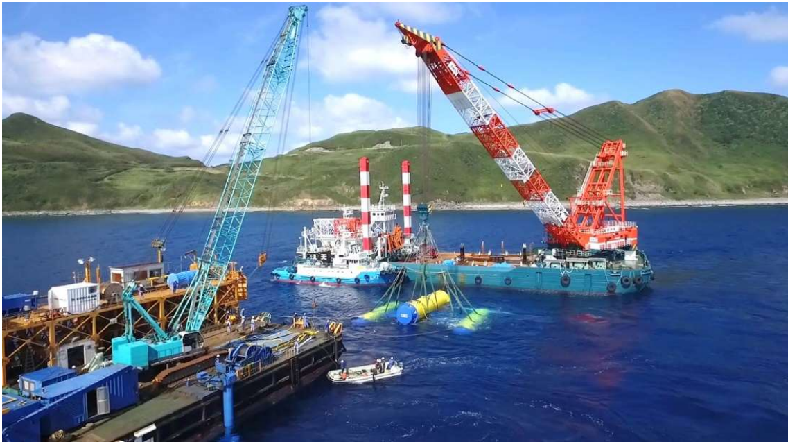
図 3.4.3 設置工事の様子
