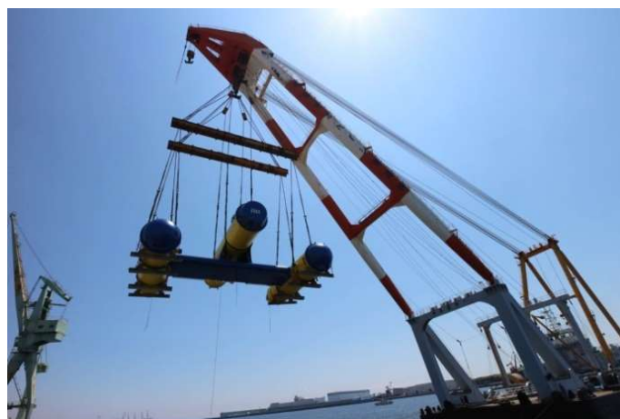
図 2.3.11 実証試験機全体吊り上げの様子
