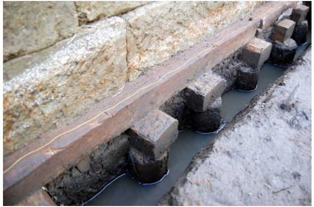
写真 2-5 藤沢宿の遺跡で見学した軟弱地盤対策基礎
