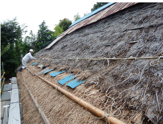
写真 押鉾竹間隔に合わせて足場丸太を吊る。
