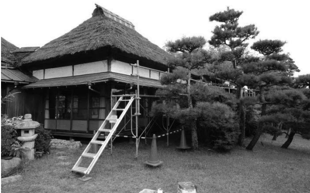
写真76 足場仮設(サンルーム棟と増築棟)
