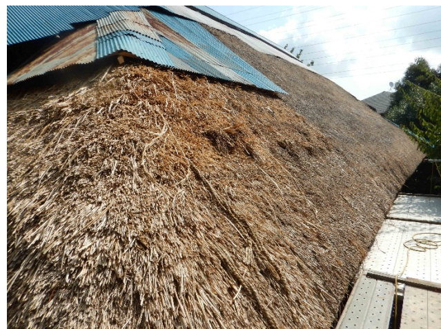
写真 足場解体前に茅葺きの気になる部分を補修して完了。
