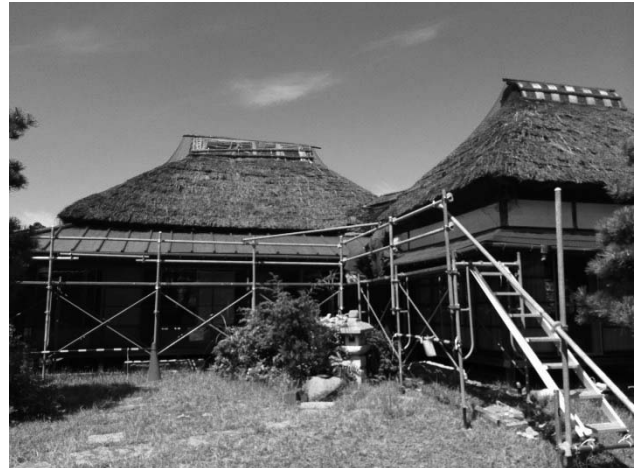
写真81 防錆塗料の下塗り（書院棟の南面庇は全面塗り替え）
