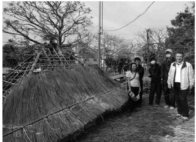
写真27 平葺き1段目の押鉾締め了 ドイツの友人も応援
