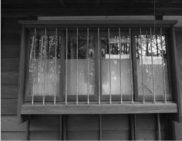
写真 115 窓鉄格子塗装修理前(増築棟背面台所)
