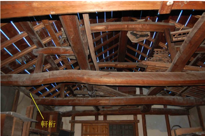
写真 3-2-2-5 潮田家米蔵(脇蔵)小屋組
