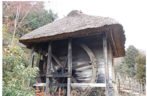
写真 2-20 日本民家園の水車小屋水車破損例 長野県から移築した水車小屋で19世紀前期頃の建築。
