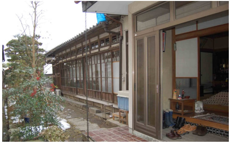
写真 2-23 森家旧主屋の軸組傾斜状況 外観 2012年2月
