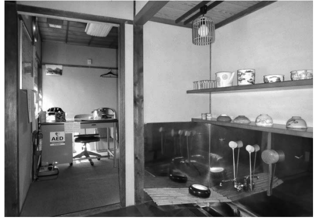
写真100 書院棟水屋に竹簀子を設置した状態(他に1箇所)
