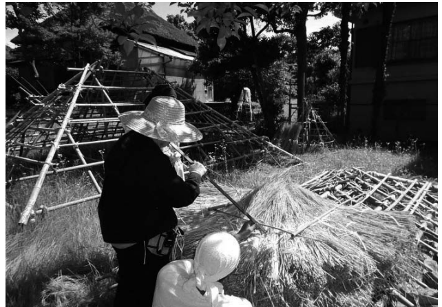
写真29 棟(グシ)積み まず品軒(小軒)を積む
