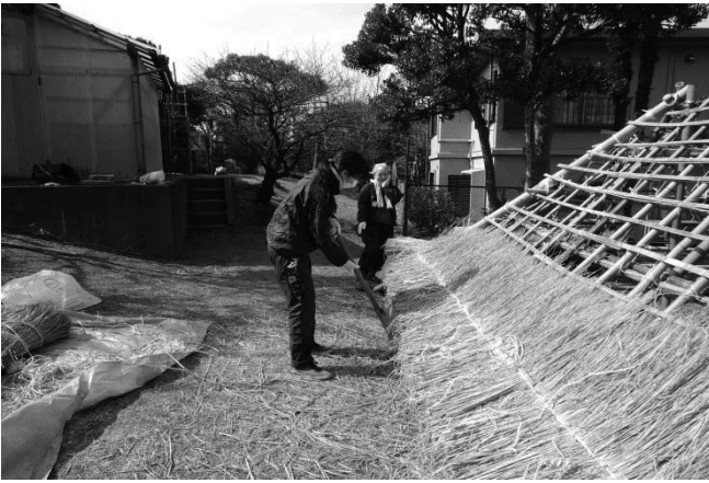
写真17 軒付下段茅(藁)を並べて縄括りし、出を揃える
