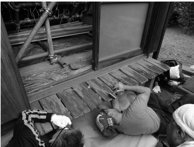
写真87 居間棟 濡れ縁造替 旧縁板解体
