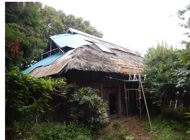
写真 この日は2 鉾(押鉾2段目)差茅を行った(終了時)
