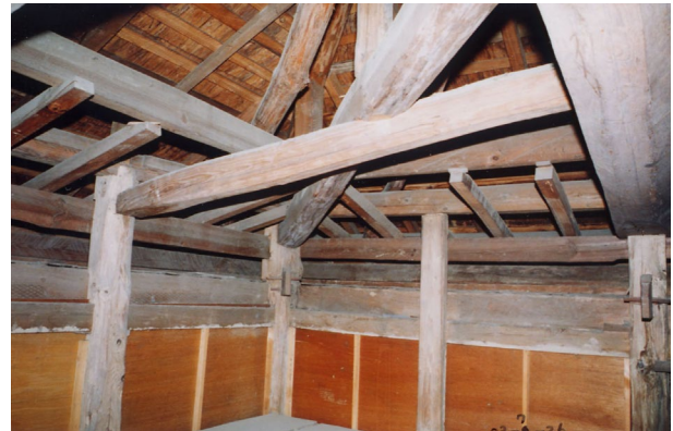
写真 6-1-6 長屋門天井裏 本来は柱の上に乗っていた梁を一段下げて現状の化粧垂木を後設している。この際、当初の梁は先端を切断しているようで、梁先の叉首の存在は確認し難い。
