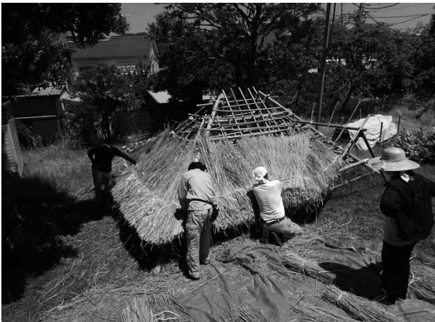
写真26 平葺き 長短の茅を巧く積み重ねて締めていく
