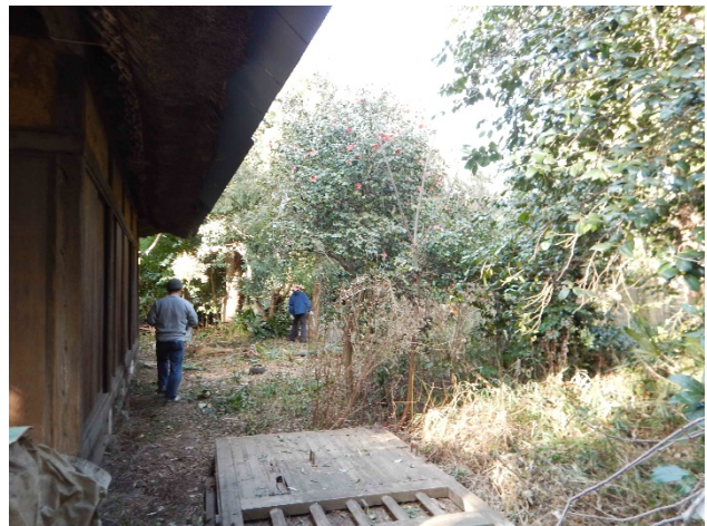
写真 東側面は屋根修理しないので必要最低限にとどめた
