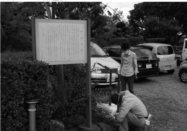
写真 133 案内板脚部塗装(錆止下塗り)
