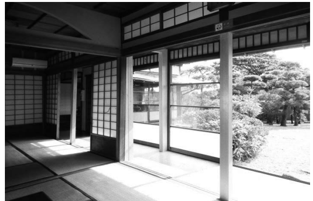
写真 104 横須賀市による書院棟軸組応急補強状況
