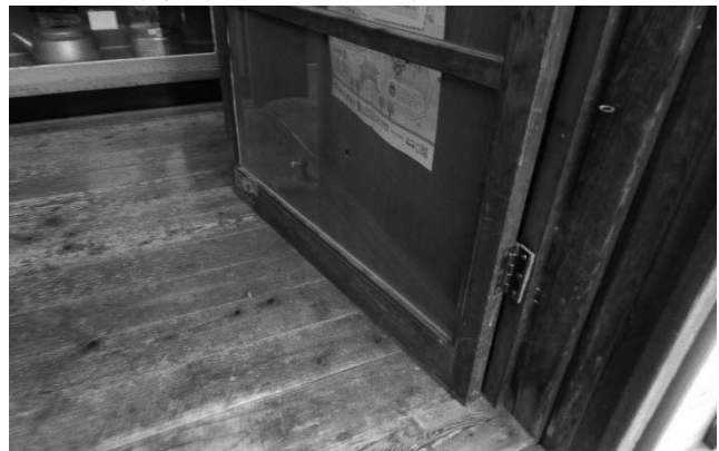
写真 114 同左 蝶番金具を調整し床面の戸擦れを解消した
