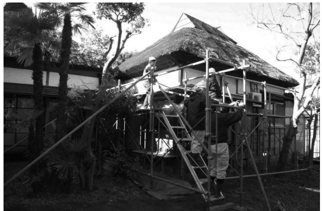
写真75 足場仮設(作業し易い高さに設定するのが重要)
