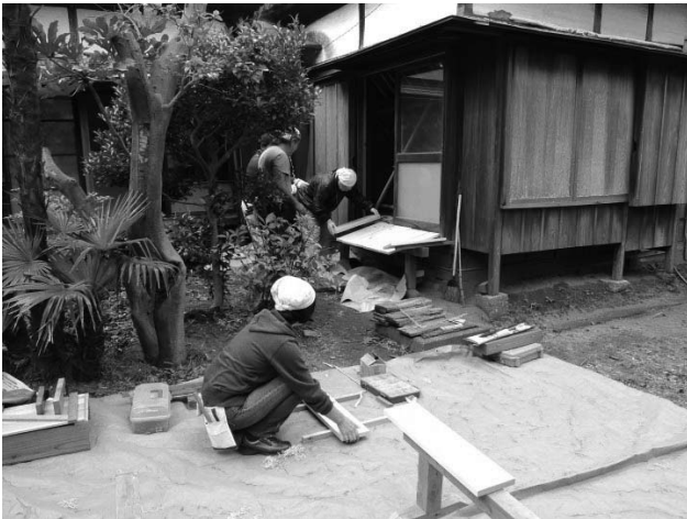
写真89 濡れ縁造替 新材縁板の仮止め
