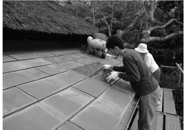
写真79 防錆塗料の下塗り（塗り進め方に十分留意する）
