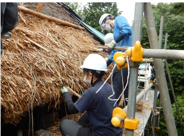
写真 密度の薄い部分に追加で差し茅する
