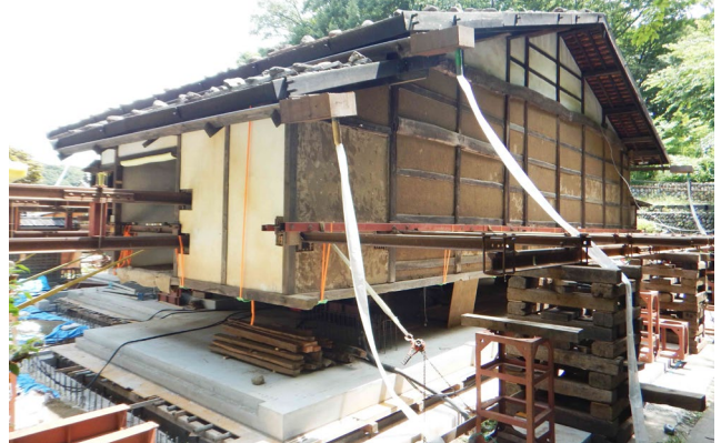
写真 2-3 旧三澤家住宅の免震基礎施工中 2017年
