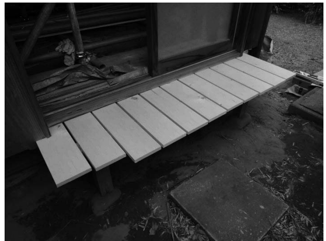
写真90 濡れ縁造替 取り付けてから出を切り揃える
