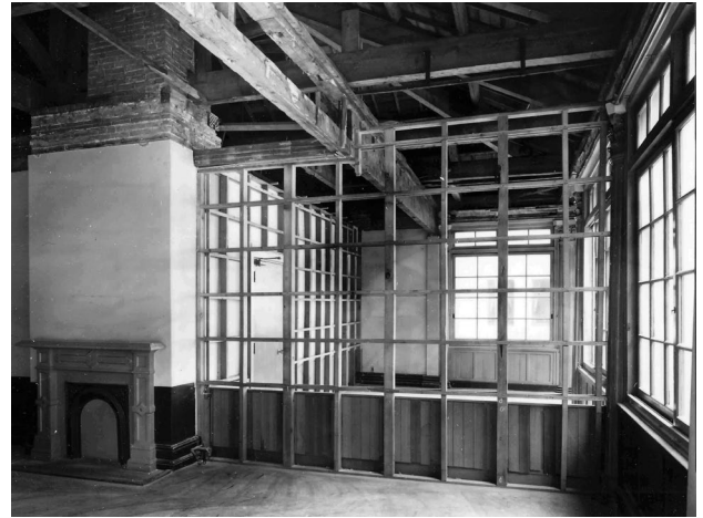
写真 2-51 旧15番館 2階のベランダ痕跡 1991年 南側2室にそれぞれ取り込まれていた。
