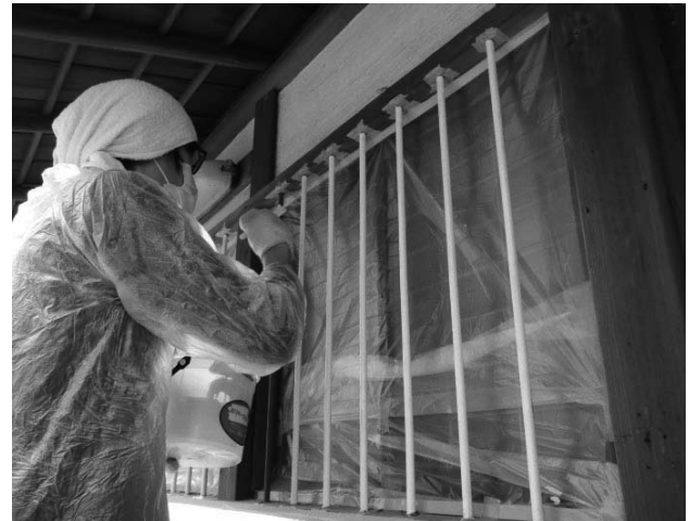
写真 120 窓鉄格子ペンキ上塗り
