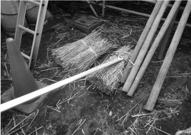
写真43 拵えた小束をまとめて茅運び棒で足場へ上げる
