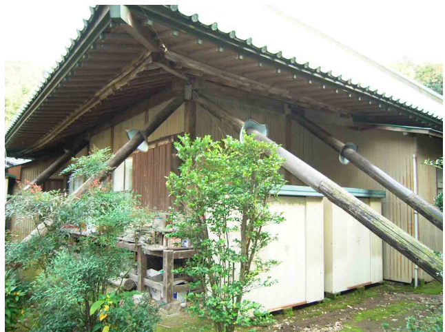
写真 2-27 横須賀市真福寺本堂背面の支柱 2004年11月
