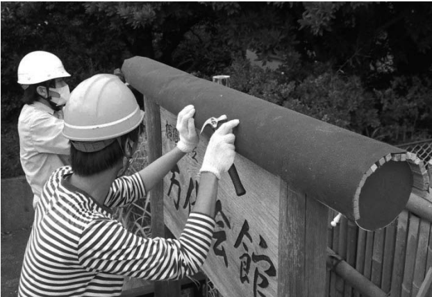
写真 137 小割材を笠木の上半部に並べて防水紙張り
