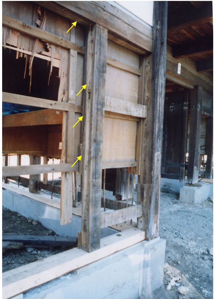
写真 6-1-4 西室正面の半葺痕跡
