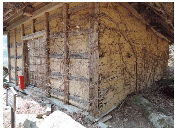
写真 2-14 千葉家住宅大工小屋 側背面
