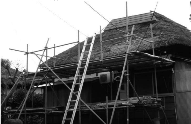
写真39 居間棟東面から差し茅修理着手
