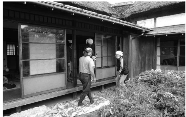
写真 108 書院棟南面建具の建て付け確認
