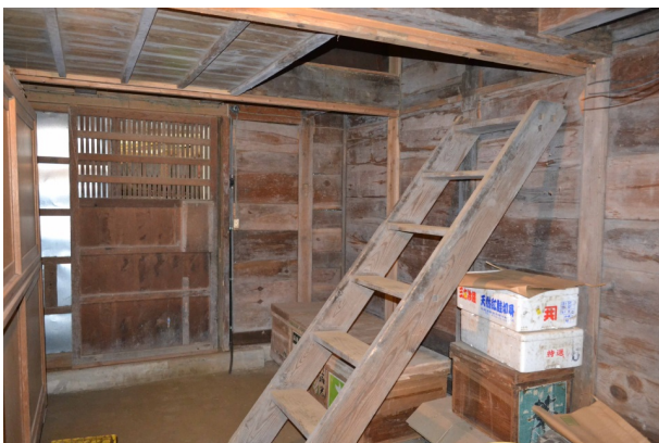
写真3-2-4-3 石井家 土蔵内部 軸組と建込式の板壁は移築前土蔵の部材をそのまま再用する。
