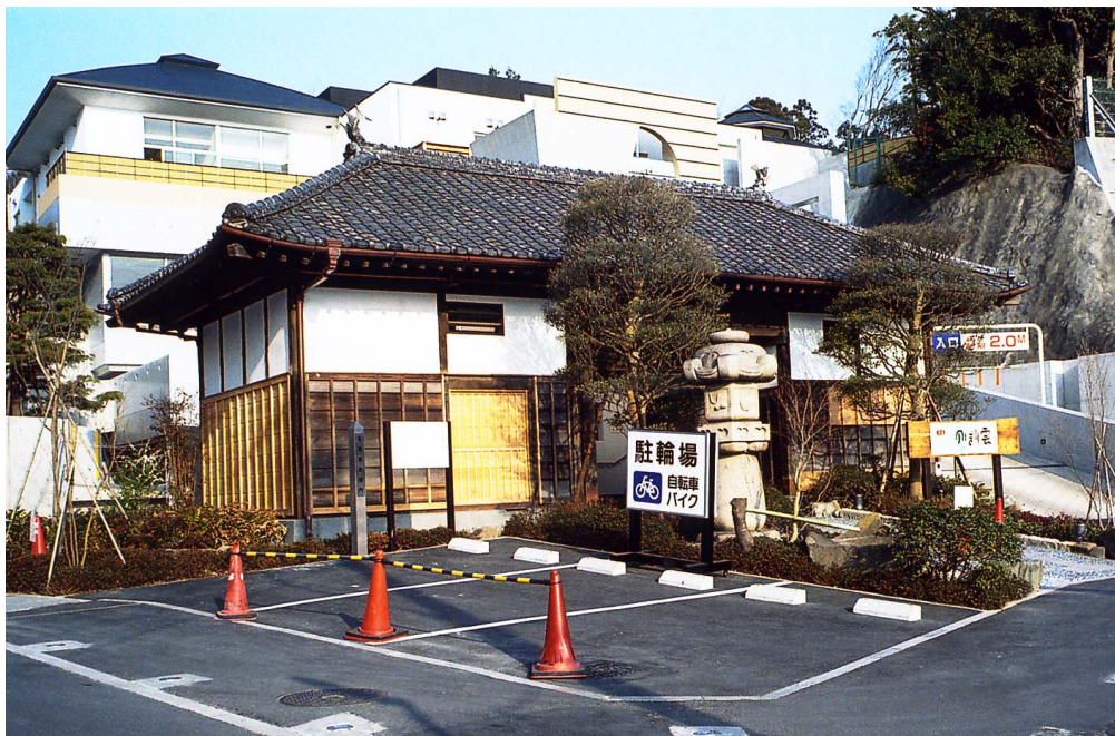
写真 6-1-7 移築修理竣工直後の長屋門 2004年
