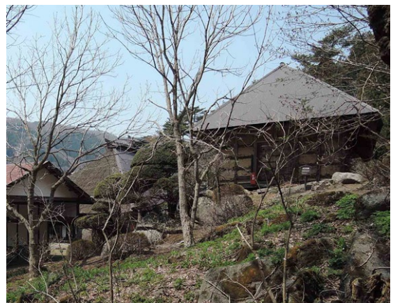
写真 2-13 千葉家住宅大工小屋 側面全景
