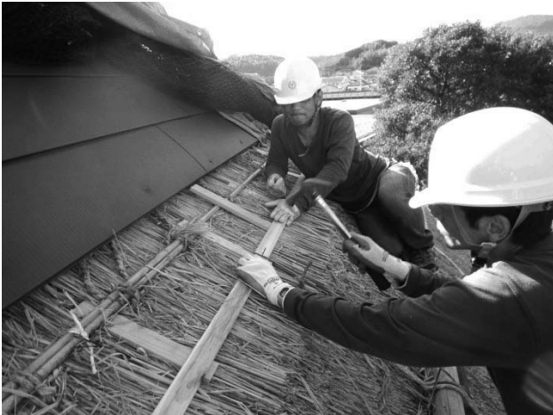
写真 57 棟際に養生の杉皮を仕込む。その下地づくり
