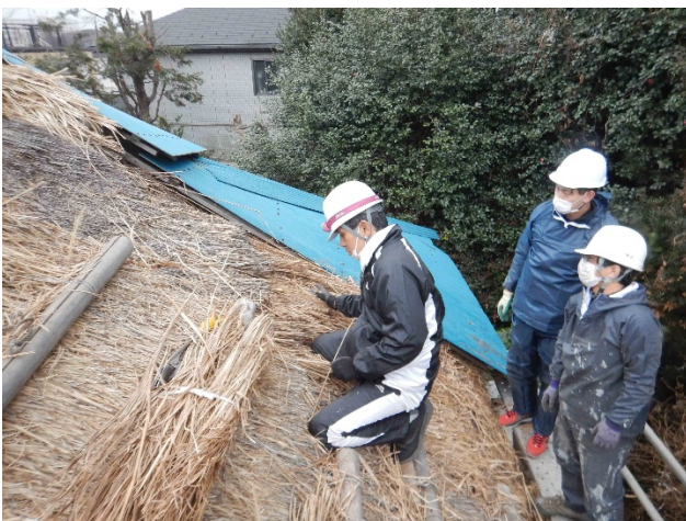
写真 東端の養生トタン際の差茅
