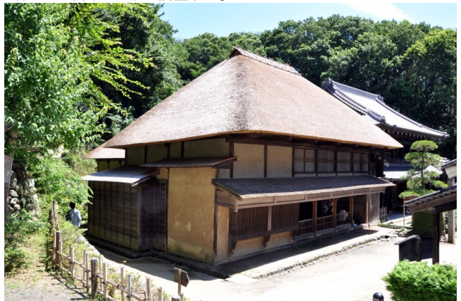
写真 2-8 耐震補強工事後の旧鈴木家住宅 2015年撮影
