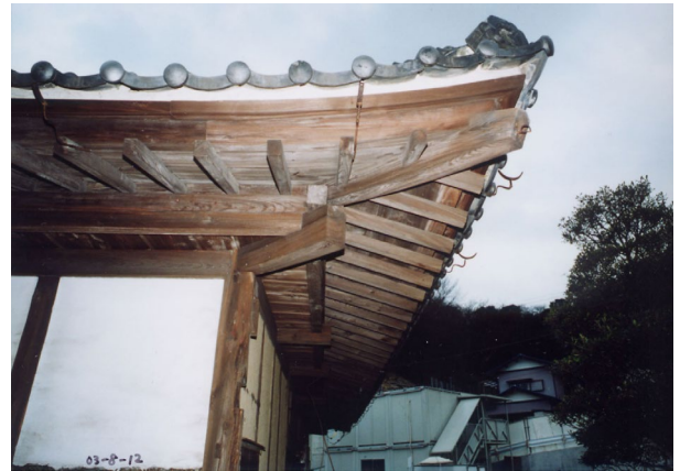
写真 6-1-5 長屋門軒見上げ 化粧垂木より先は新しい
