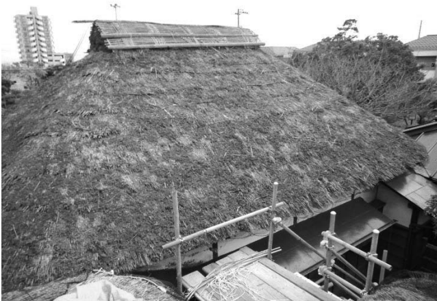
写真37 書院棟背面(北面)修理前
