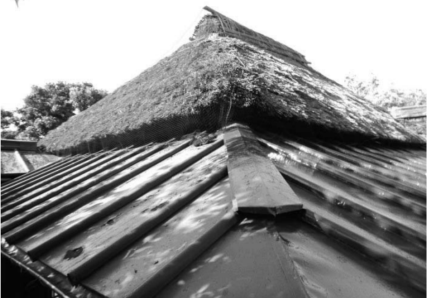
写真84 書院棟庇の未着手面（左）と上塗り終了面（右）
