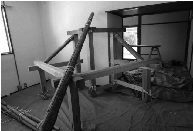
写真11 隅部の骨組 この上に竹を組んで下地とする
