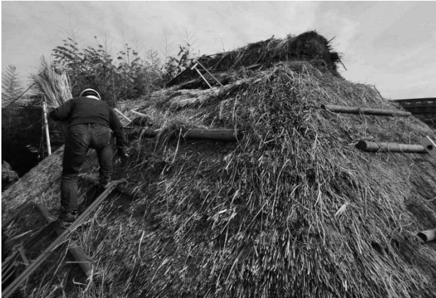
写真 59 居間棟の旧竹簀子棟取り外し
