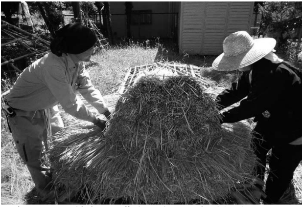
写真 30 次に棟方向に茅束を積み上げて括り付ける
