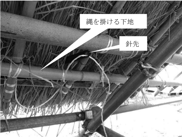
写真19 軒付上段茅の押え竹(押鉾竹)を仮締めして出を揃える
