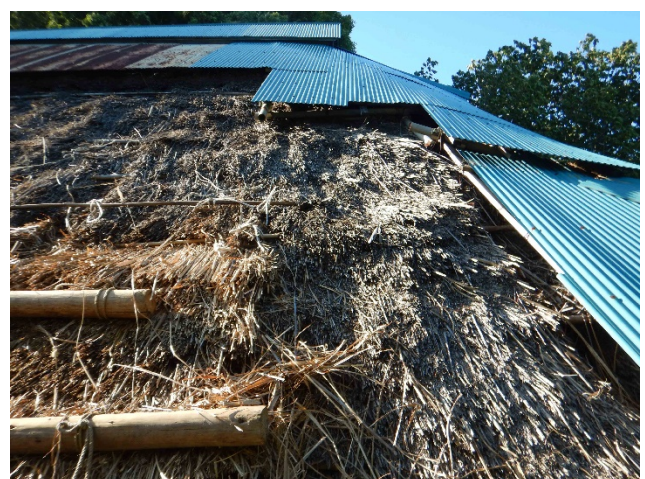
写真 右側のトタンは応急の養生で設置したもの。
