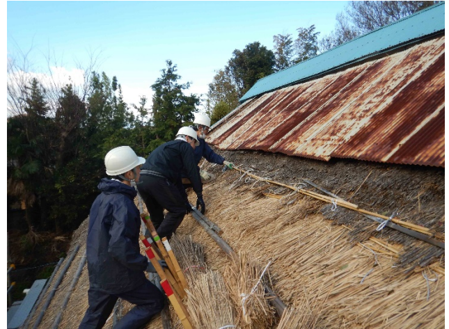
写真 8 鉾目の施工法の説明
