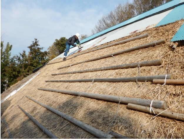
写真 東半刈り込み前 養生鉄板のペンキ塗り仕上げ
