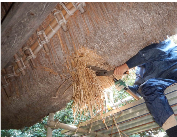
写真 軒付部を刈り込んで差した部分を整える
