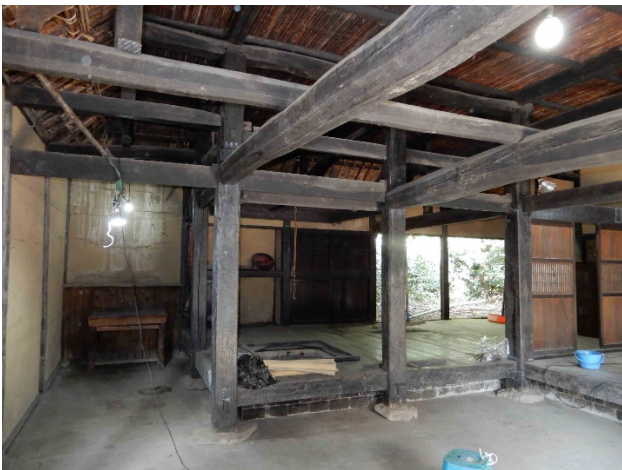
写真 荷物搬出後の土間 躯体は健全で風格がある
