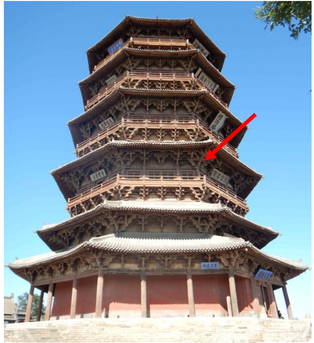
写真 2-24 仏宮寺積迦塔塔 全景 2014年9月 2層目の軸組の内転びが特に激しい（矢印）
