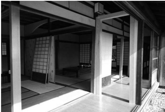
写真 105 書院棟軸組応急補強状況 外から見る
