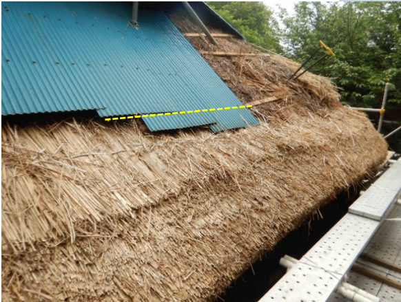
写真 西面北側から(作業前)トタン裾を切りそろえる
