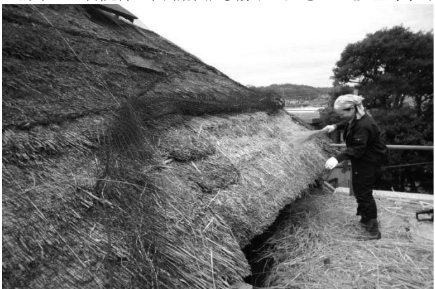
写真40 居間棟東面差し茅 養生の漁網を外して作業する
