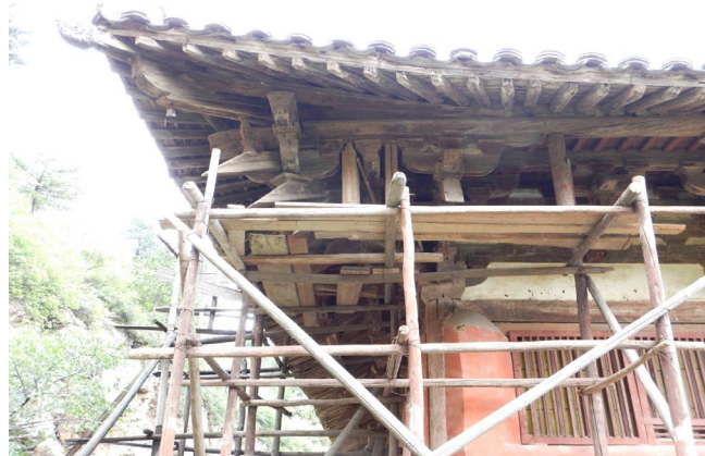
写真 2-26 仏光寺大殿背面西隅の応急補強 2014年9月 足場を組んだまさに「応急補強」であるが、目立たない場所なので、「これ以上傷みが進まないように支えておく」ことは妥当。
