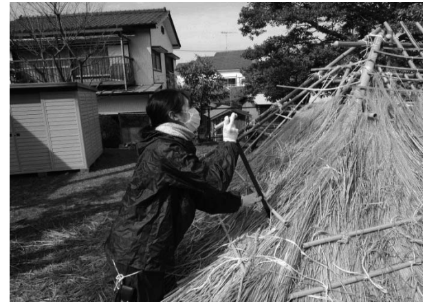
写真20 鉾竹を締める縄は「針取り」で下地と絡める
