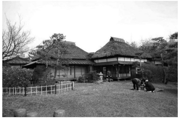
写真2 左から玄関棟・書院棟・サンルーム棟・増築棟
