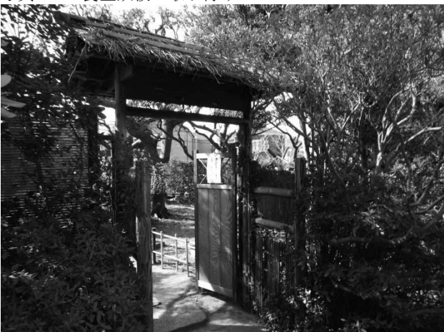
写真 141 木戸正面 屋根と控えを補修した
