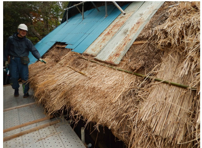
写真 西面の補修方法を試してみた状態
