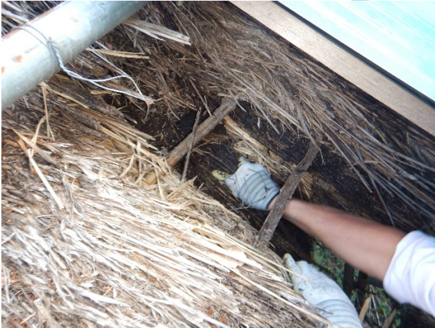
写真 東端のトタン際の傷んだ茅をまとめて引き出す
