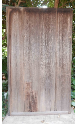
写真 潜り戸の板破損部繕い (表面と裏面)
