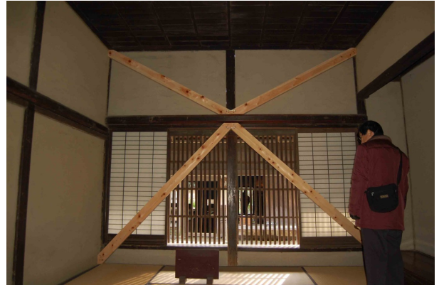
写真 2-9 軸部傾斜調査後に応急的に筋違補強した
