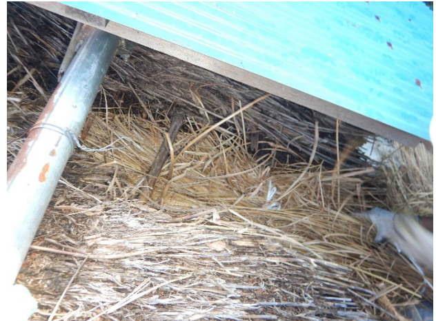
写真 引き出した後に先細に拵えた茅束を差し込む
