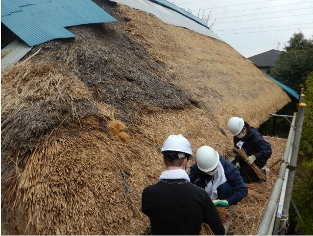
写真 正面西隅 軒際の差し茅
