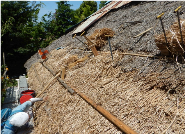
写真 3 鉾目に着手 葺き上がりの勾配を確かめる
