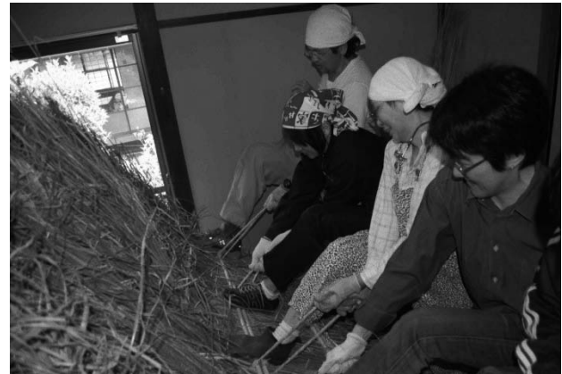
写真14 平葺き 茅を積み並べて押銚竹で締める
