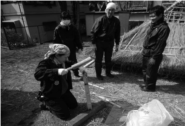
写真24 軒先を押さえる「パイ(割竹)」をつくる
