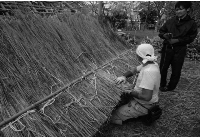
写真19 軒付上段茅の押え竹(押鉾竹)を仮締めして出を揃える
