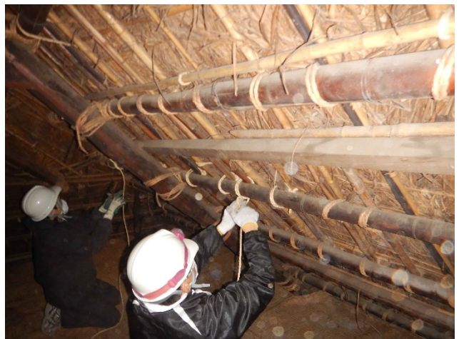
写真 屋根下地の縄縛り補修
