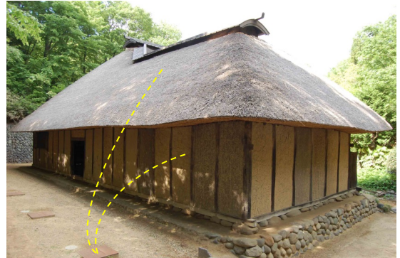
写真 2-19 壁面の水かかり被害例 防災水道設備のドレンチャー(水幕装置)は、放水たちあがり時に壁面に水がかかることがある。そのため訓練時には壁面養生が必要である。
