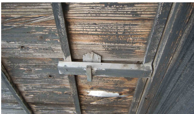
写真 3-2-2-3 同上下見板壁の押え木
