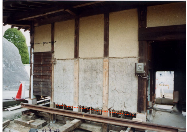
写真 6-1-2 永島家長屋門揚家中の足元の状態 土壁の状態は良好で、足元の点線部に壁止を挿入すれば土壁は再用可能である。
