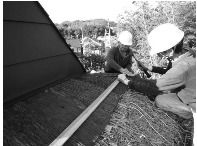
写真 58 棟際に養生も杉皮を取り付ける
