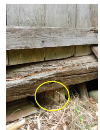
荒巻家住宅の土台を支える地東
