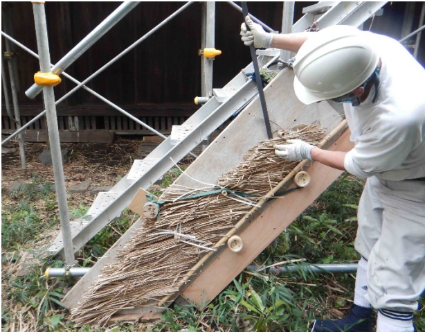
写真 模型で茅葺きの仕組みを復習(針の取り方)
