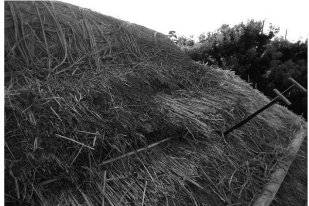
写真 60 棟際の差し茅の様子 押鉾竹を取り直している
