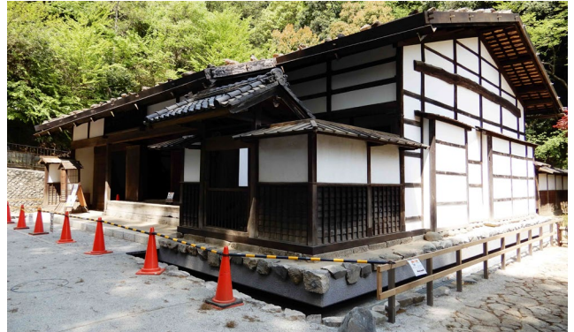
写真 2-4 旧三澤家住宅の免震基礎竣工後の外観 2017年
