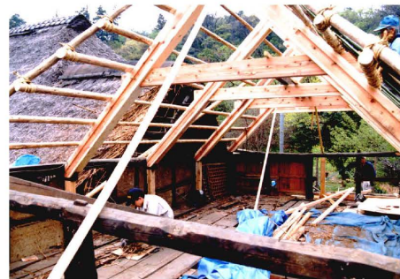
馬屋は明治19年に小屋裏の梁を切断して蚕室化(移築時?)。さらに平成5年貳屋根裏部屋に改修
