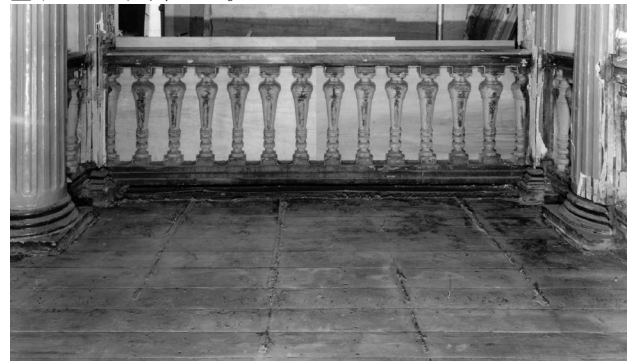
写真 2-53 旧15番館 2階ベランダの防水工法 1991年 床板上に獣毛フェルトを敷き、ズック布を幅54cmくらいに敷き、重なり目を銅鉾で止め、ペンキ塗りした痕跡が残っていた。
