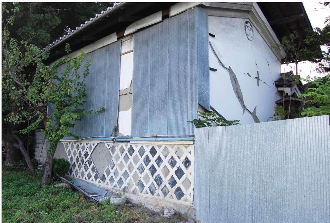
写真3-2-1-2 土蔵の波型鉄板養生の例 (長野) 2009年撮影
