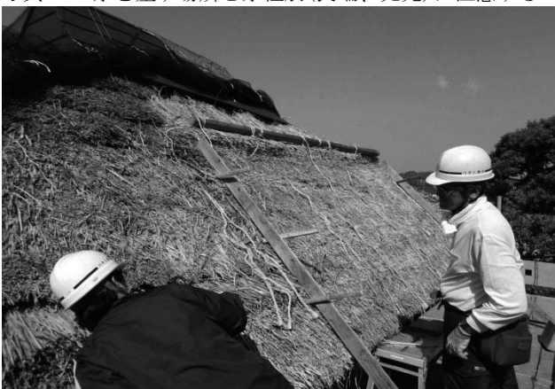
写真47 葺き地の状況を常にチェックしながら進める
