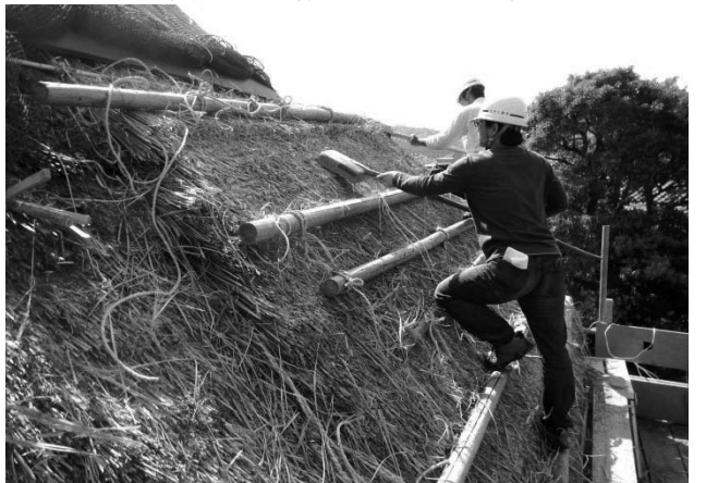
写真 54 葺き地はコテを使って叩き均して平滑にする
