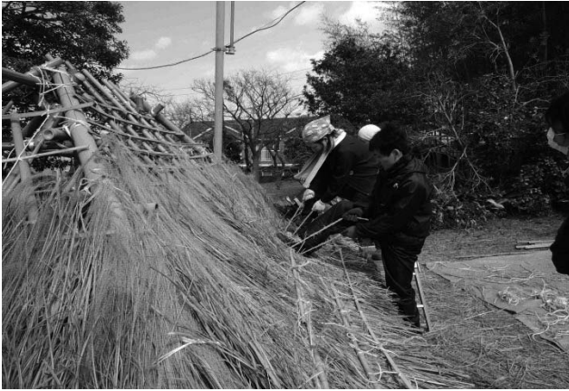
写真22 押鉾竹をとっくり結びして締める
