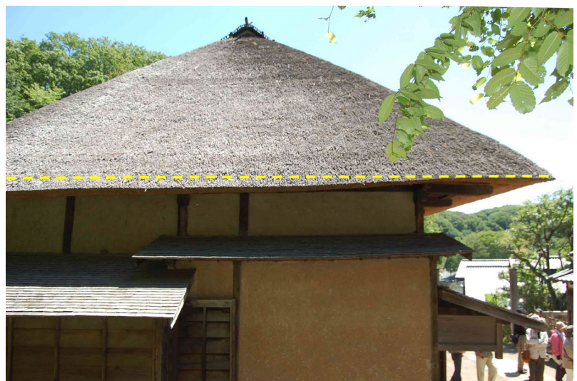
写真 2-39 きれいな仕上がりをみせる茅葺における軒線課題例 屋根面はきれいに仕上がっているだけに側面の軒線の乱れが惜まれる。
