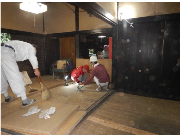
写真 座敷の一部も荒床破損部を補修した。
