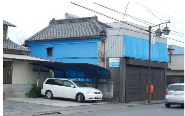
写真3-2-1-1 土蔵造町家の波型鉄板養生例 (群馬)
