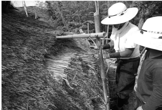
写真46 茅を差す場合に補助具を用いる場合もある
