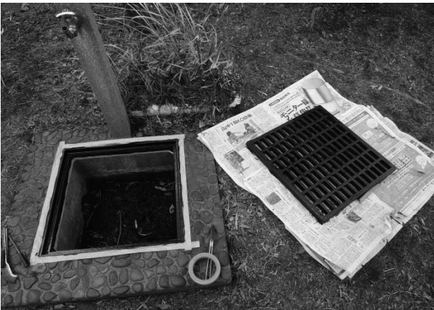
写真 129 水道排水口蓋塗装
