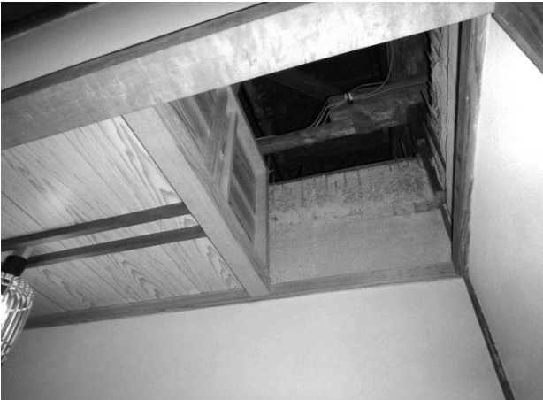
写真101 水屋天井改め口改修後(上方開き戸形式に変更)
