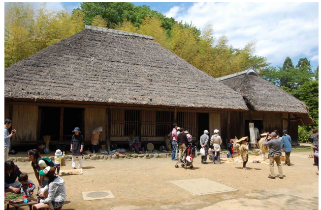
写真 2-40 民家の前ニワに設備関連施設が露出している例 様々なイベントが行われる重要な空間の雰囲気が損なわれた。
