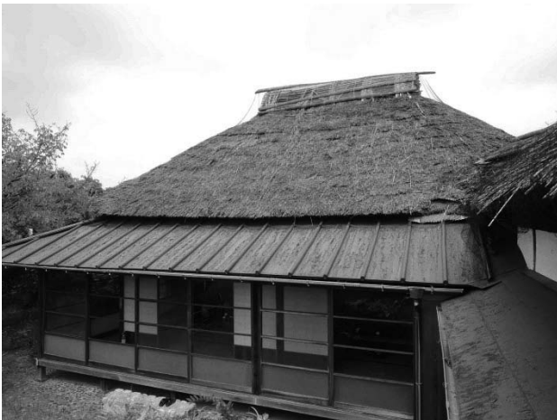
写真72 書院棟南面庇屋根の修理前(右はサンルーム棟)
