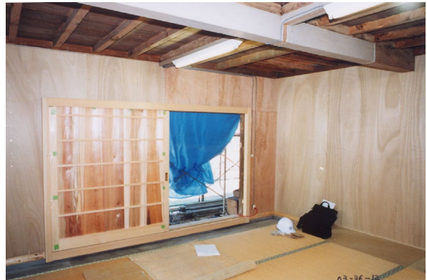
写真 6-1-3 西室屋内の背面見返し 大戸口は痕跡に基づき復原した。この部屋は元来板床だが大戸の存在により入口のみ土間であったと考えざるを得ない。
