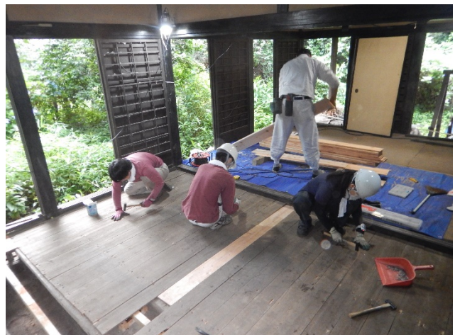
写真 荒床板張り 板腐朽部は新材を張って防腐剤塗布した
