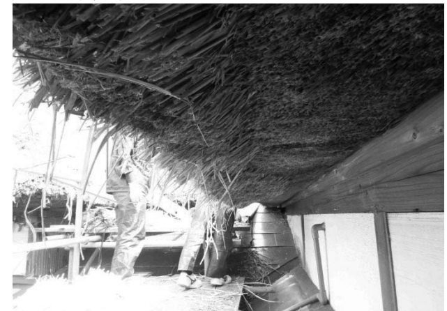
写真 68 書院棟 軒先の差し茅状況確認（撮影：石田陽是）
