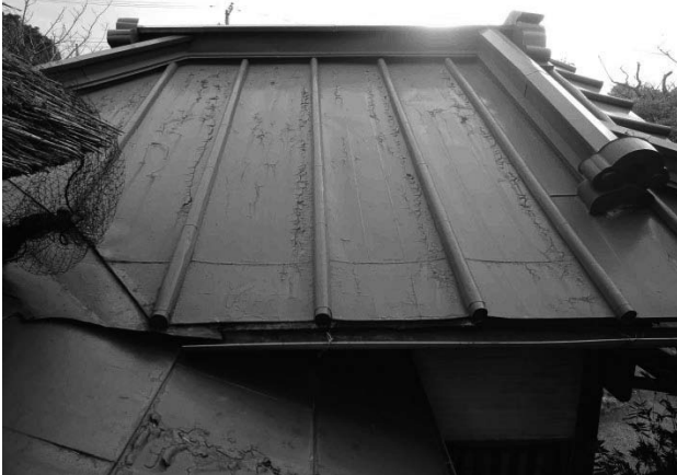
写真74 玄関棟東面屋根の修理前(手前は書院棟背面庇)
