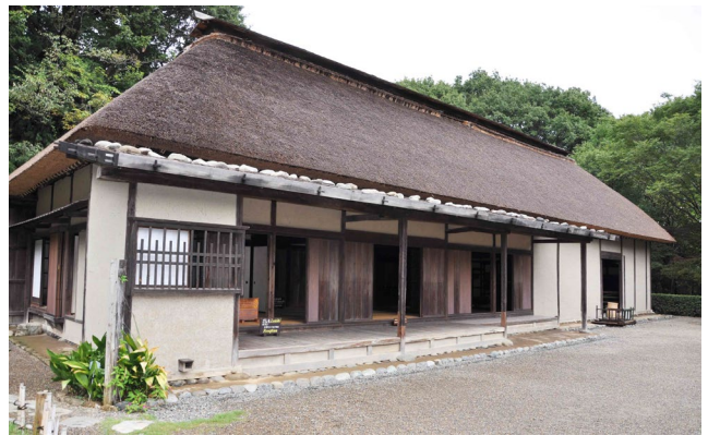
写真 2-2 基礎是正工事終了後の旧佐々木家住宅 2010年
