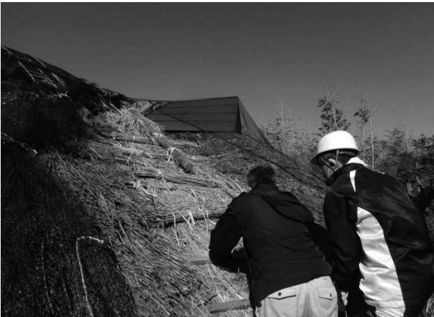
写真 51 茅束を簡易足場として差し茅を行った
