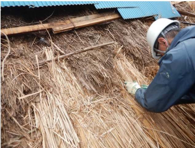
写真 西面の補修方法を試してみる
