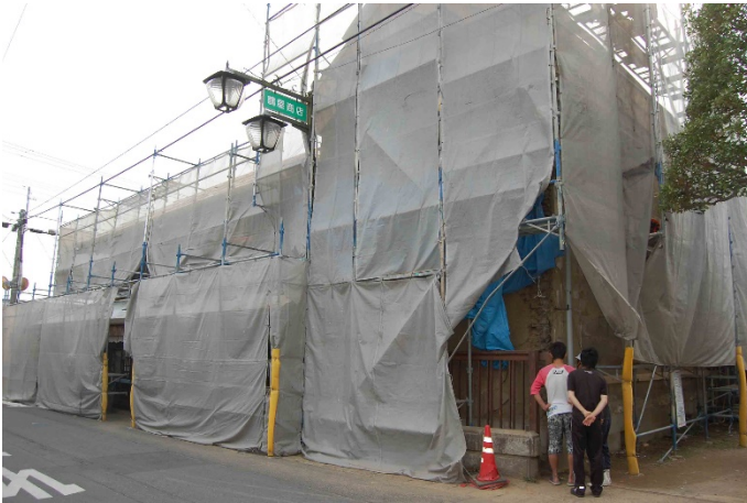
写真 3-2-2-8 潮田家袖蔵・塗屋の修理状況
