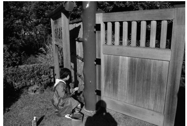
写真 132 門扉塗装・扉蝶番金具塗装
