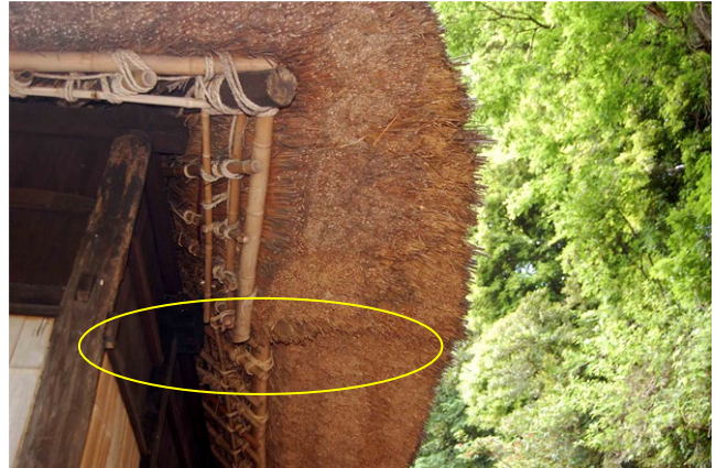
写真 2-38 妻側屋根を修理する場合の修理範囲検討例 通常ならば線引あたりが修理継ぎ目になるが、本当にそれよいかは現場の状況をよく確認して判断すべきである。
