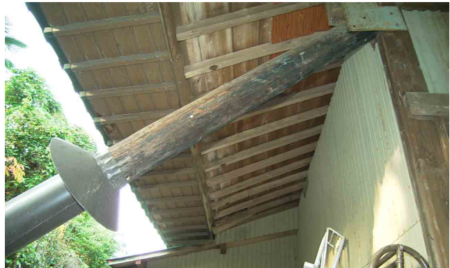
写真 2-28 同上 支柱の詳細 雨除けの金属製「傘」まで備えている。
