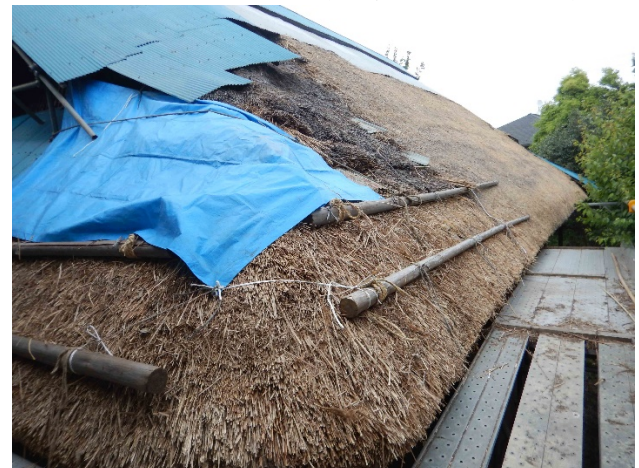
写真 隅は上段を仮止め(左写真)して養生し本日は終了
