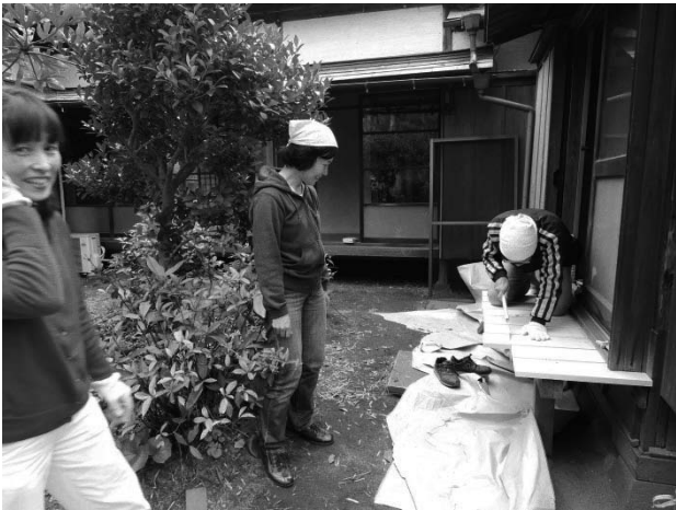
写真91 濡れ縁造替 縁板の出を切り揃え作業中
