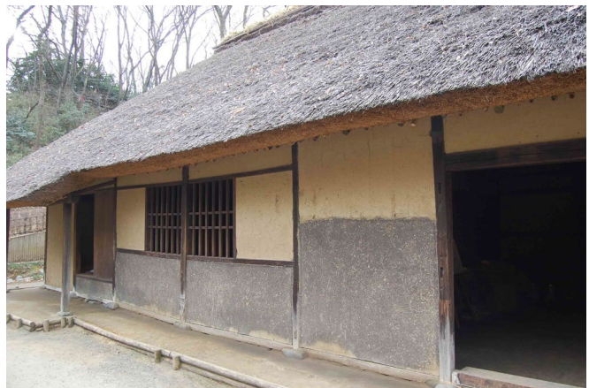
写真 2-1 旧清宮家住宅正面の不同沈下 川崎市多摩区から移築した住宅で、建築年代は17世紀中期頃まで遡る可能性がある。園内最古の古民家である。
