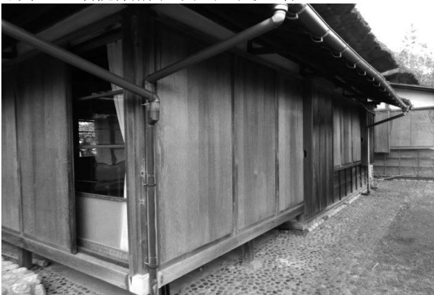
写真 111 サンルーム棟 雨戸建て付け調整後
