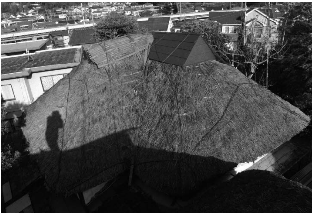
写真35 居間棟(管理棟)の屋根 この修理を主目標とする
