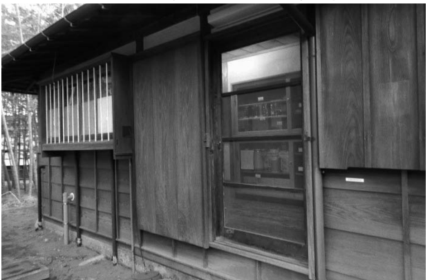
写真 113 増築棟勝手口 網戸蝶番金具調整
