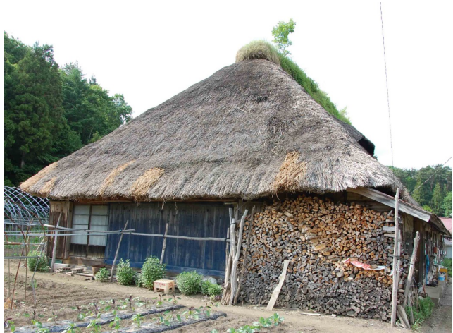
写真2-32 茅葺きの差し茅修理例
