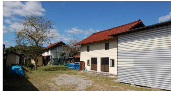
写真 3-2-3-2 同上 屋敷背面から正面を見る 真中に米蔵、前方に内蔵と居室棟が見える
