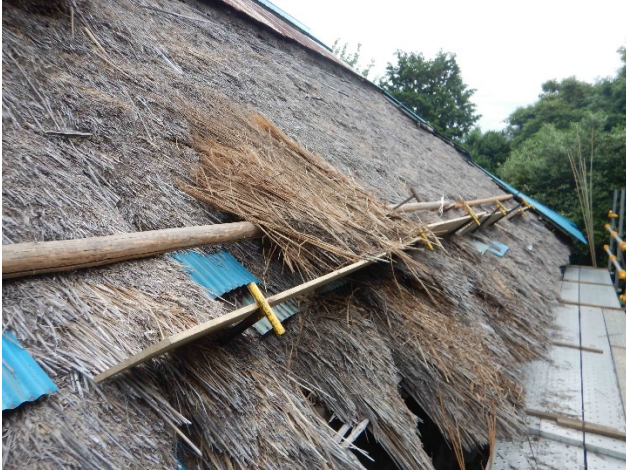
写真 軒先付近から修理開始 古茅も再利用を検討した
