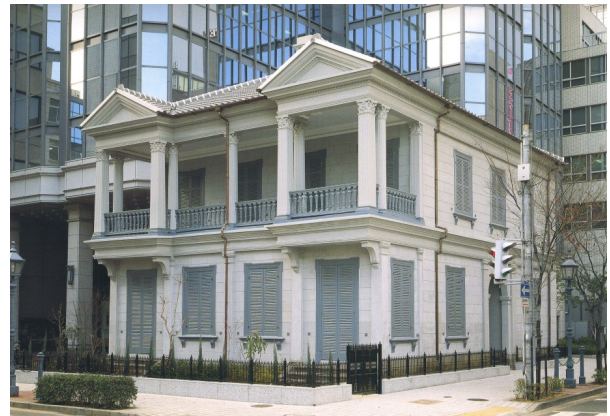
写真 2-43 旧15番館 最初の修理工事竣工 1993年
