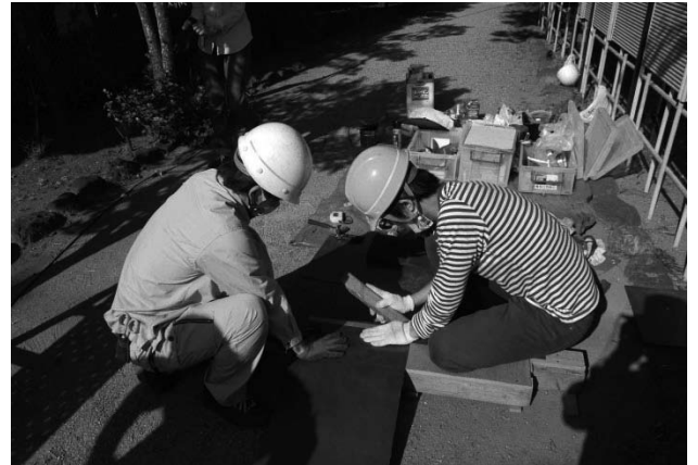
写真 138 養生鉄板ハゼ加工
