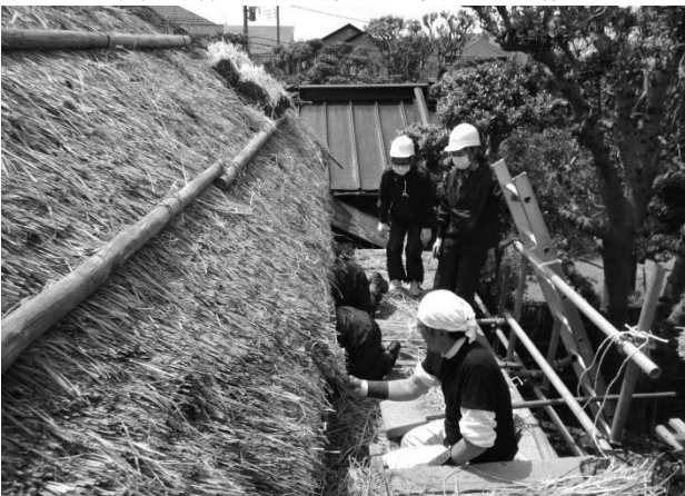
写真 67 書院棟 差し茅 叩き込みと軒先の確認
