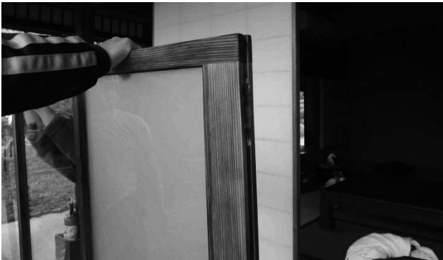
写真 109 書院棟南面建具の戸車取り替え
