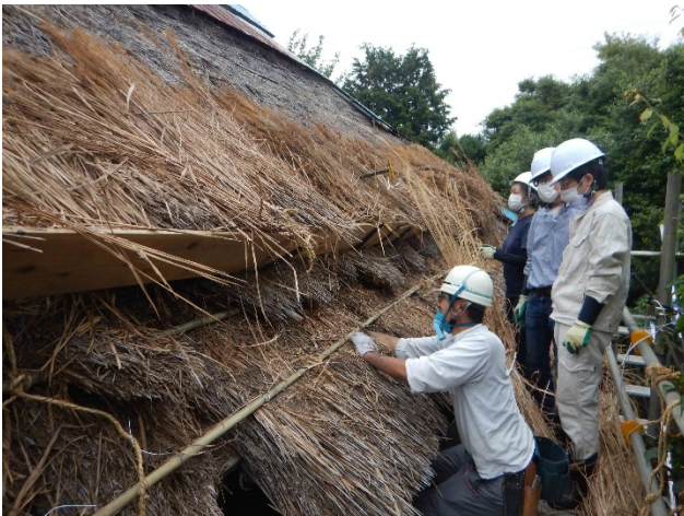
写真 押鉾竹の取替てほかの修理の方法説明を受ける
