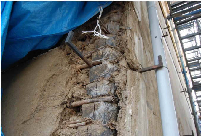
写真 3-2-2-9 潮田家袖蔵東北隅柱の露出状況
