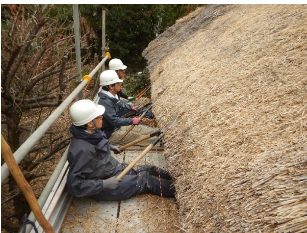
写真 軒先の刈り込み 軒先に糸を張って目安にする
