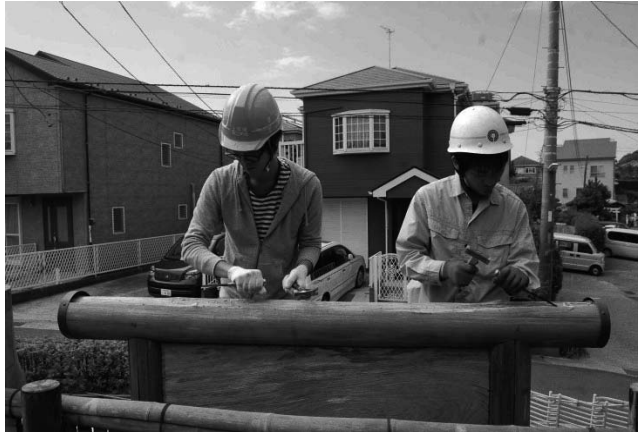
写真 136 看板笠木上端の腐朽部削り
