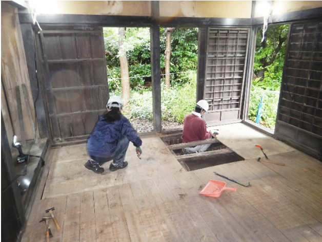
写真 納戸の荒床めくり 一度すべて外す
