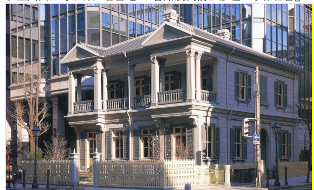
写真 2-45 旧15番館 震災復旧竣工 柵と門扉形式に注意
