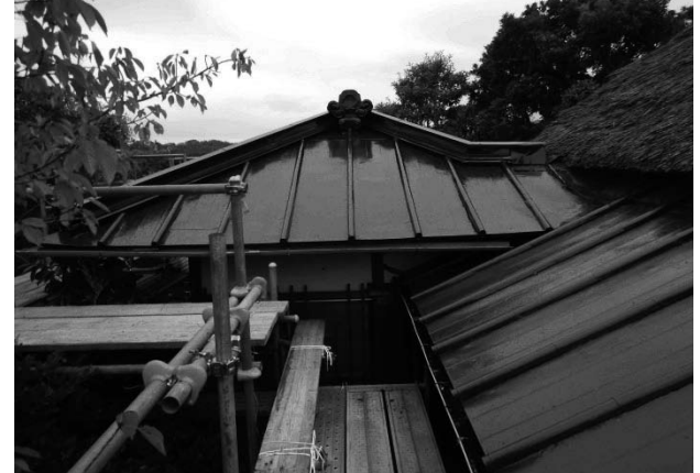
写真85 上塗り終了（玄関棟背面と書院棟西庇）
