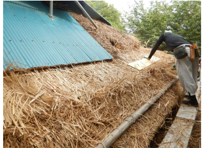
写真 ひと通り並べたらトラ縄で仮締めしてから均す
