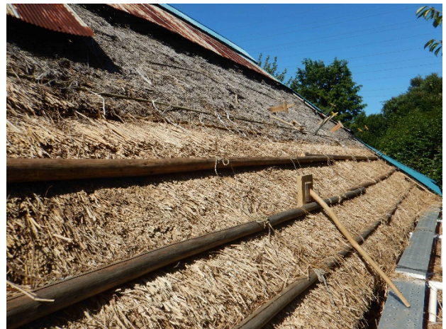
写真 左の状態から葺き地を叩き締めて均した状態
