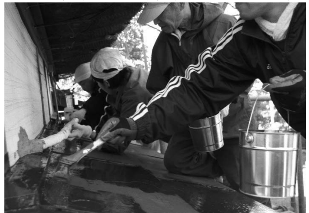
写真83 上塗り仕上げ（刷毛使いひとつにもコツがある）
