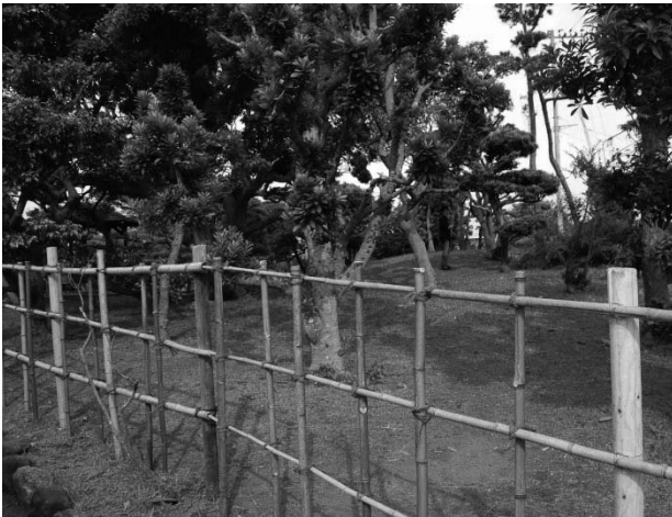
写真 123 四目垣補修後
