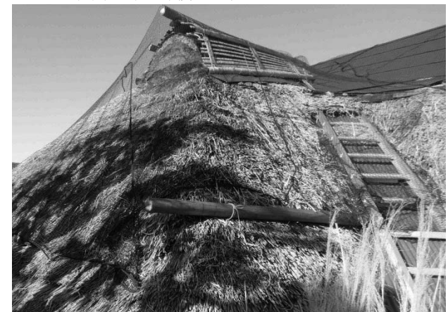
写真 64 居間棟の茅葺き修了了 (撮影:石田陽是)
