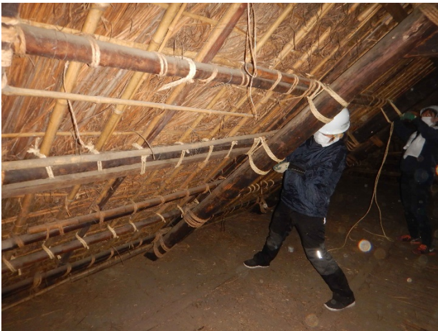
写真 屋根下地の縄縛り直し (又首と屋中)
