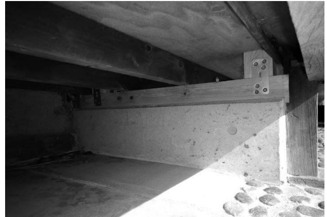
写真 106 同左 縁側補強の床下部詳細
