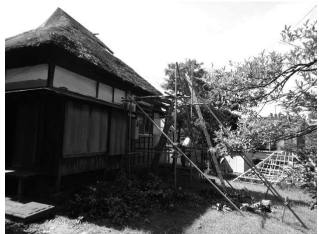
写真 126 居間棟東脇の植栽枝払い
