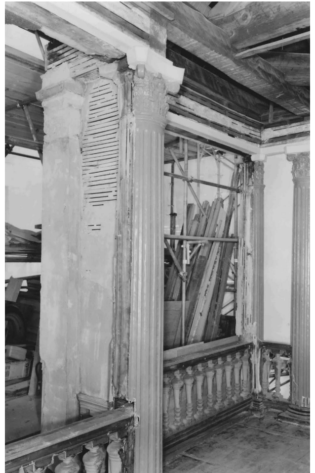
写真2-55 旧15番館 2階ベランダ正面の柱型 1991年 ベランダ内側の柱型は比較的よく当初形状を留めていたが、外側の柱型は、外壁の塗り重ねとともに形式が変化しトスカナ式に造り替えていた。
