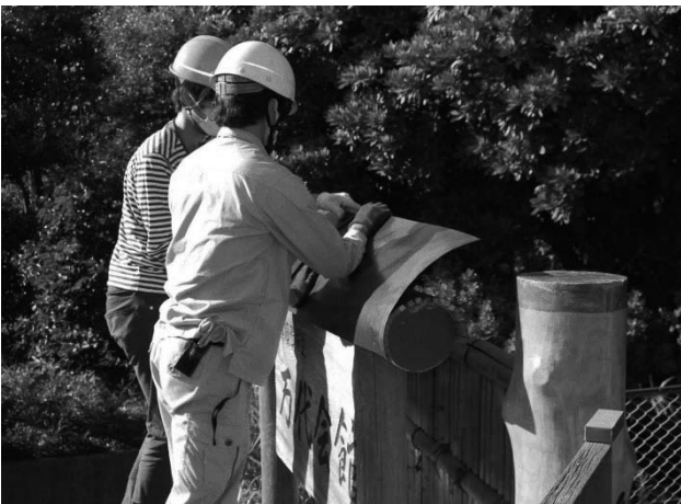
写真 139 養生鉄板の取り付け
