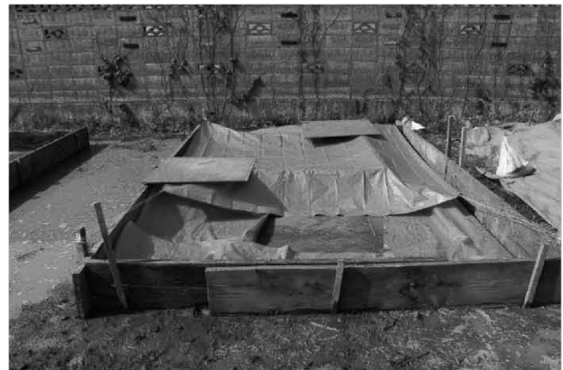
18. 壁土練り場の養生
