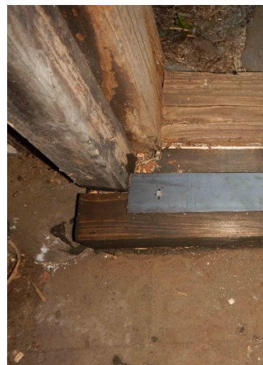
写真 付敷居上に鉄板敷した。戸車を取り替えた。
