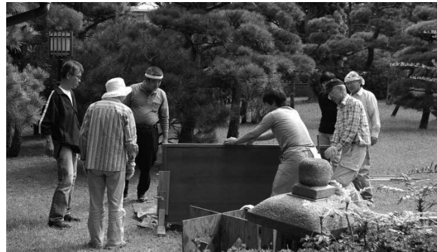
写真 110 書院棟・サンルーム棟 雨戸の框調整
