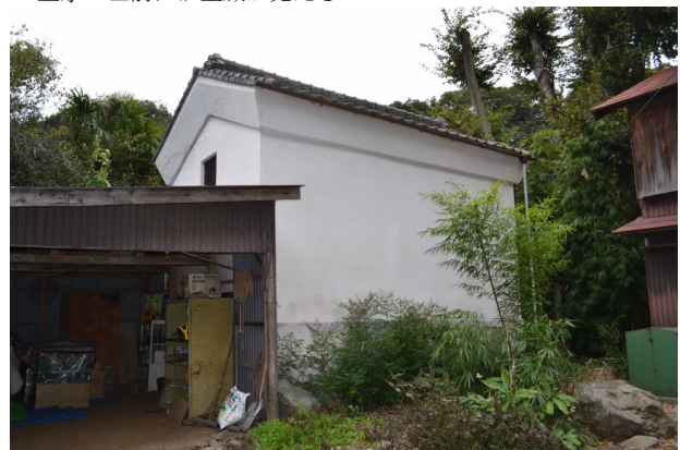
写真3-2-4-2 現状の土蔵 旧土蔵が破損したので、戦後に近隣から土蔵を移築した。外観は土蔵風だが土壁は施工せず、鉄骨とボード下地である。
