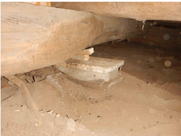
写真 大引中央下の支えを調整する
