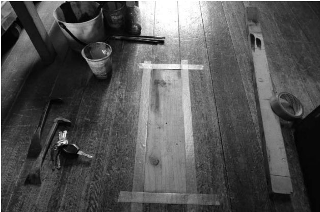
写真93 納戸 床板割損部の部分張替と古色塗準備
