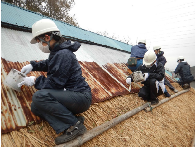
写真 屋根養生鉄板のペンキ塗り
