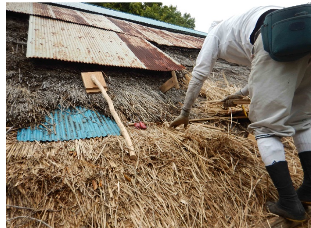
写真 作業終了時は押鉾縄が濡れないよう鉄板養生する
