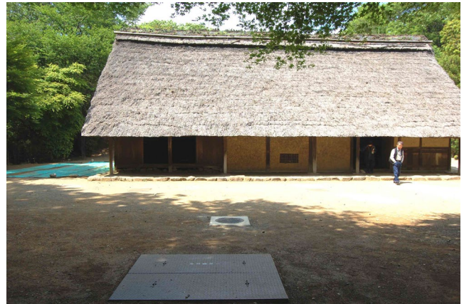
写真 2-41 同上 別の民家の事例 写真前方に設備を移すことは十分可能であった。
