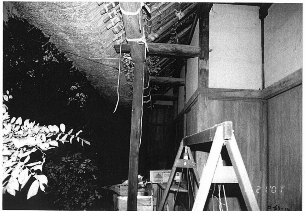
4. 「奥座敷」前の土庇から「広間」前の土庇を見る
