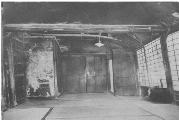
ひろしき内部 (くちなんど方を見る)
