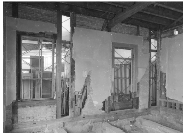
写真 2-50 旧 15 番館 1 階西南室の軸部補修 1991 年 土台は全取替した。柱や筋違は腐朽部のみ継木した。施工は経験豊富な長谷川棟梁が丁寧に作業してくれた。この継木部分は倒壊時にも破損しなかった。
