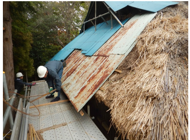
写真 足場を西面に架け直す
