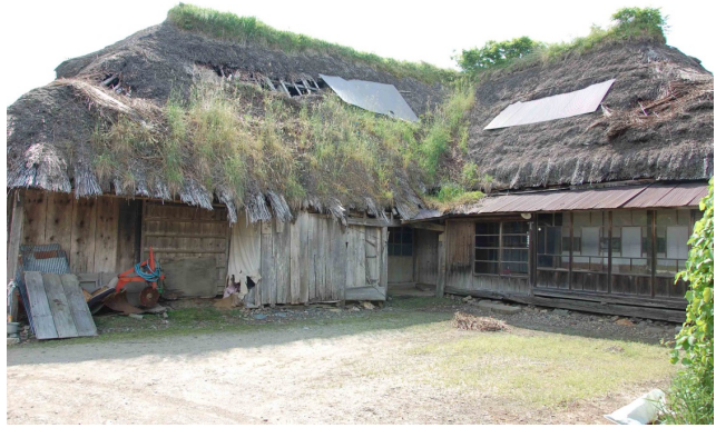
写真2-31 茅葺きの破損が限界を迎えている状態
