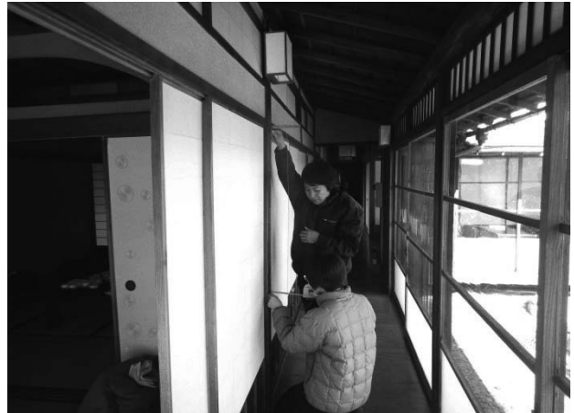
写真102 書院棟 軸組傾斜調査
