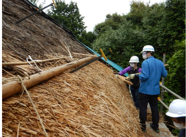
写真 コテで表面を叩き均す
