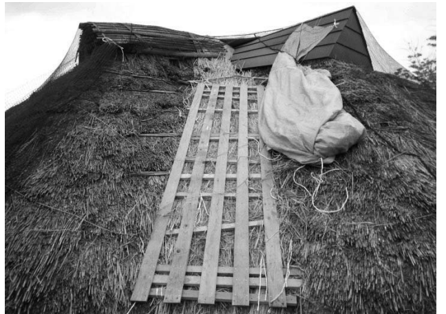
写真 52 鉄板養生用の枠をつくり波形鉄板張りする
