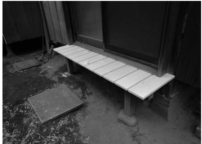
写真92 濡れ縁造替 完成
