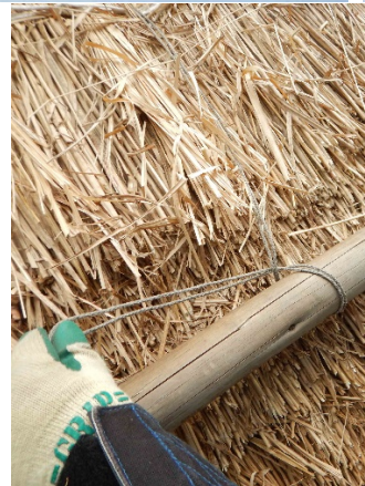
写真 足場丸太を吊る(足場丸太の結わえ方)
