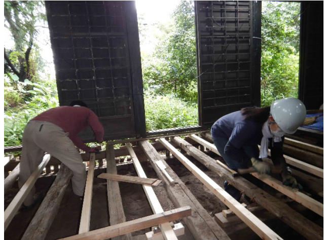
写真 根太の中間に補強根太挿入する (高さ揃えに注意)
