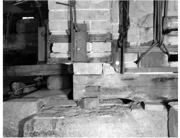
写真 2-48 旧 15 番館 揚屋の支保工 1990 年 土台を取り替えるためにレンガ壁体の足元において、レンガ目地に 2 段にアングル鉄骨をかませてジャッキアップした。この方法は持田武夫先生が考案したものである。
