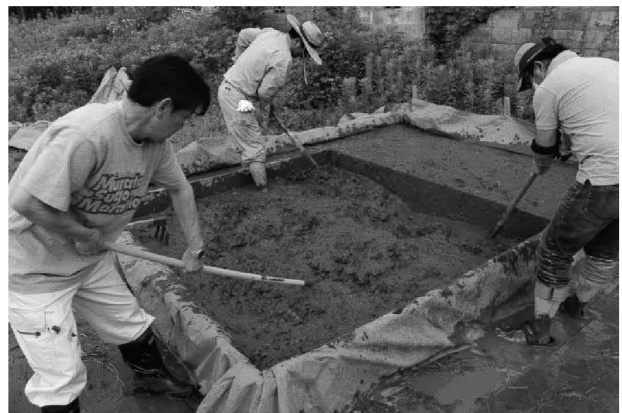
2-9. 作業終了後の壁土づくり
