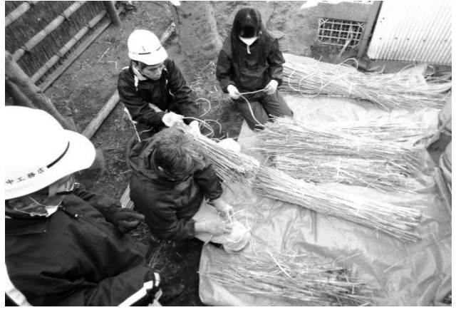
写真42 茎主体の小束、穂先を混ぜた小束などを拵える
