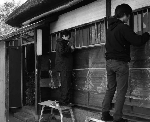
写真 117 窓鉄格子塗装ケレン時の養生(居間棟背面)
