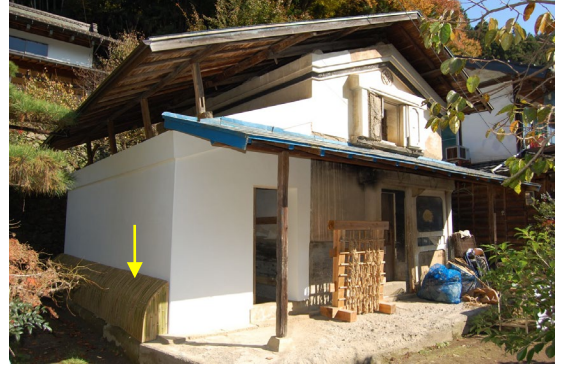
写真 2-16 足元の養生例
