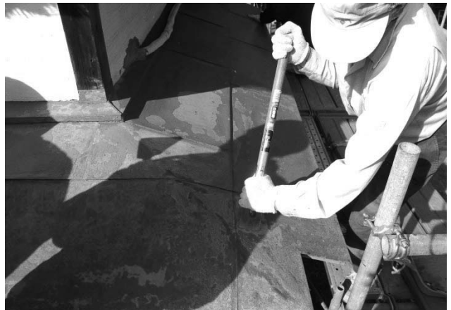
写真77 ケレン(鉄板を傷つけず掻き落とすのがコツ)
