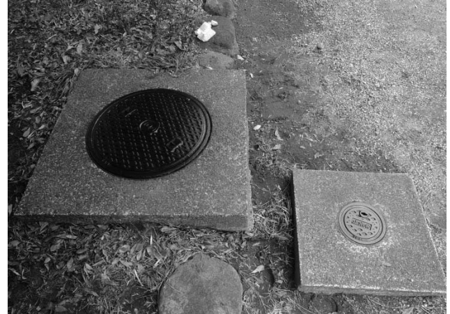
写真 130 マンホール蓋・水栓蓋塗装
