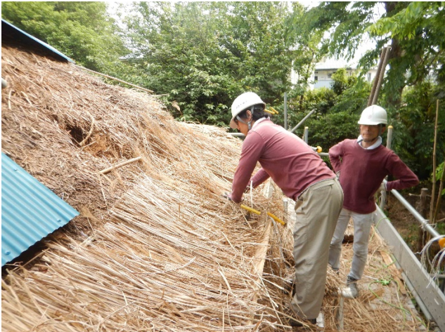
写真 前回の茅積を押銚で押さえ、裏茅を並べる
