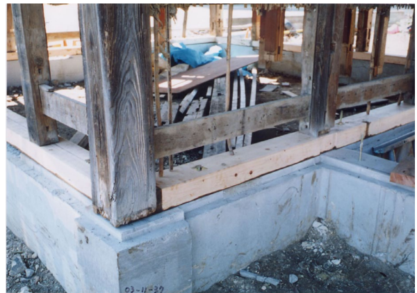
写真 6-1-1 永島家長屋門柱足元施工中
