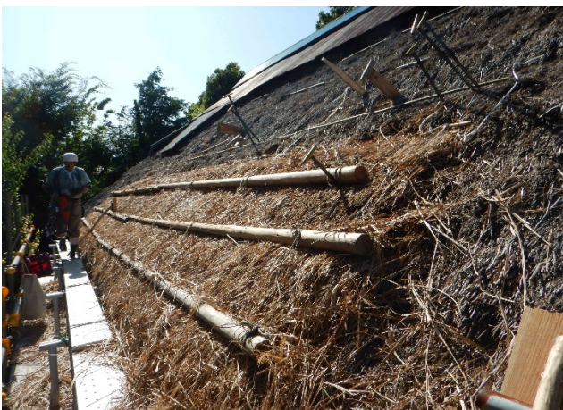
写真 3 鉾目まで差して足場丸太を吊った状態
