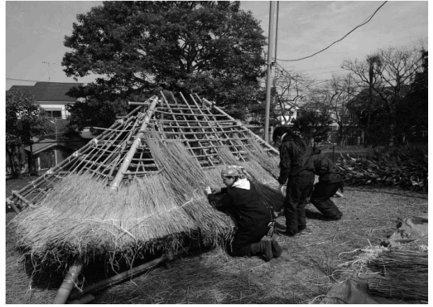
写真18 軒付上段茅(ススキ)を並べて縄括りする。
