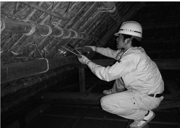
写真 53 針取して押鉾竹を取り付け直した部分もある
