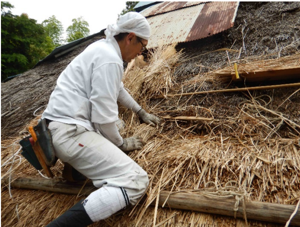
写真 鉾下に柔らかい茅束と硬い茅束を順に差し込む
