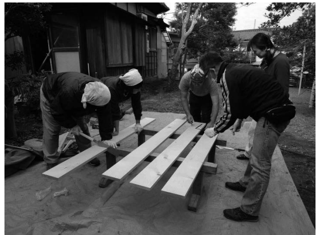
写真88 濡れ縁造替 新材縁板の木取りと加工
