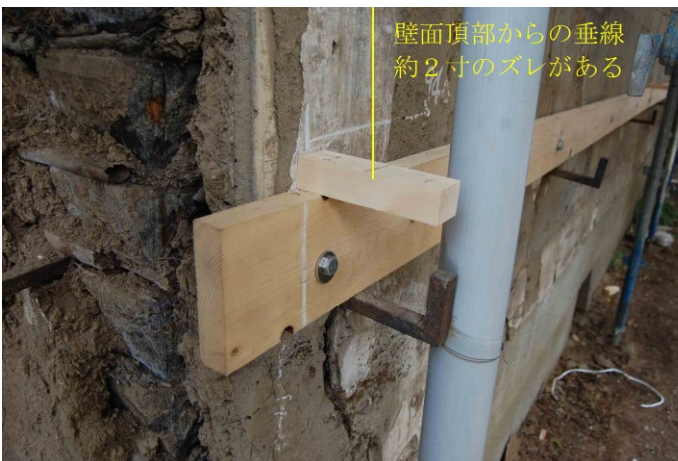
写真 3-2-2-10 潮田家袖蔵 北面の補修状況
