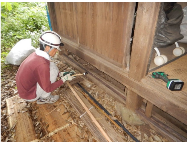
写真 尺杖(定規)により割付を記して豎格子を取り付ける
