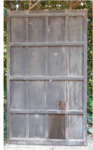
写真 潜り戸の板破損部繕い (表面と裏面)
