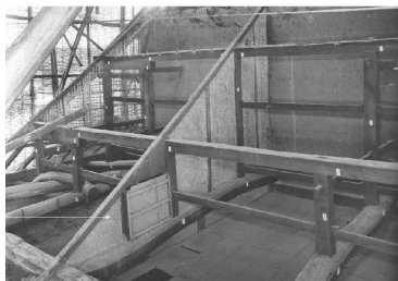
主屋2階の後設小壁 部屋間仕切増設に対応
