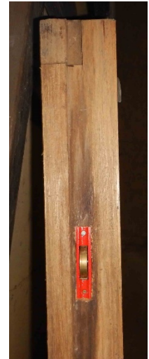
写真 付敷居上に鉄板敷した。戸車を取り替えた。
