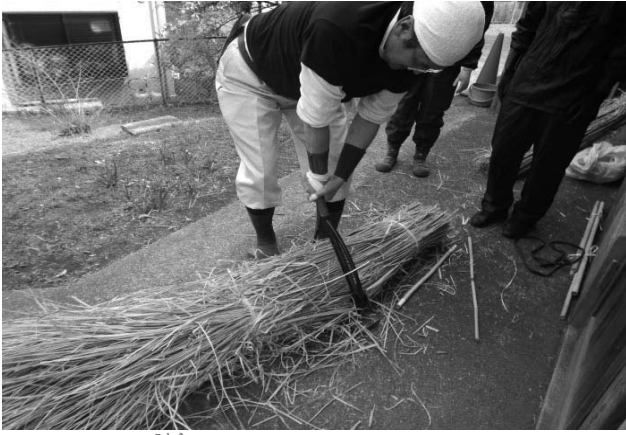
写真41 茅の拵え 2.5尺、3尺などの長さに伐る
