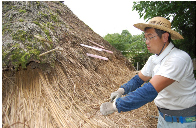
写真2-33 茅葺きの修理例 表面を葺き替える
