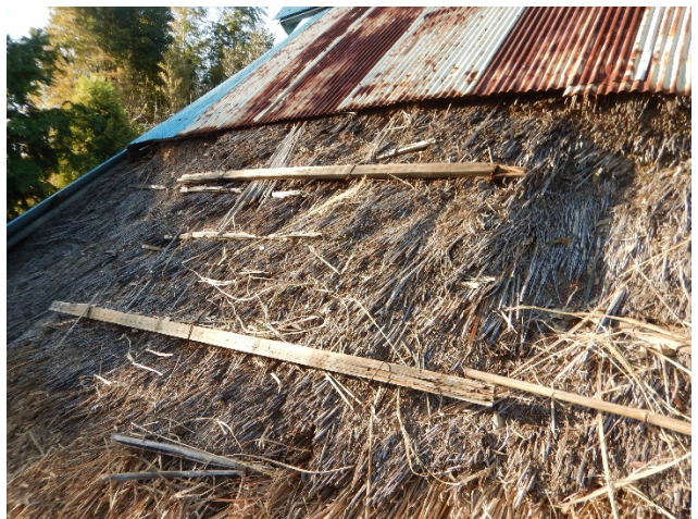
写真 正面西端の養生鉄板を15年振りに外す。
