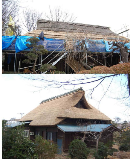
施工中正面(上)と竣工背側面(下)
