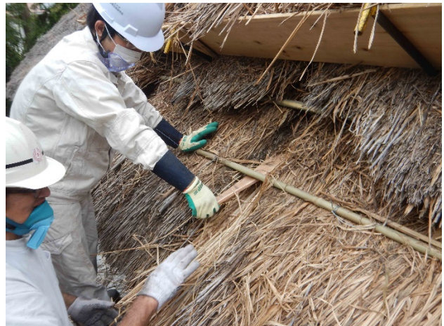
写真 道具をうまく使って押鉾竹下に茅を差し入れる
