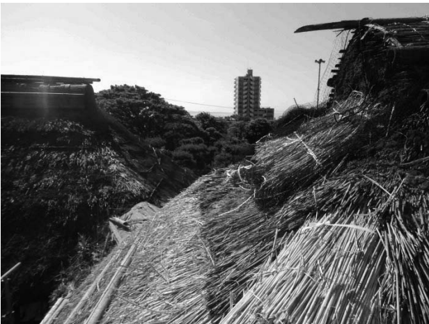
写真 71 書院棟 東面差し茅 棟際と隅のおさまり
