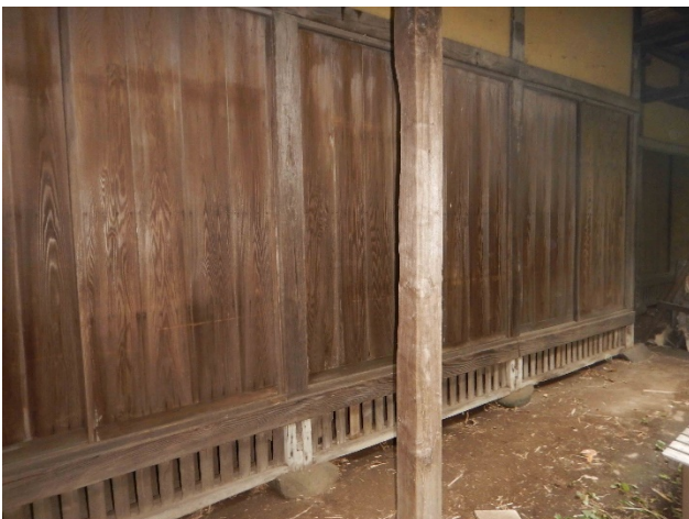
写真 犬塞ぎの修理了。
