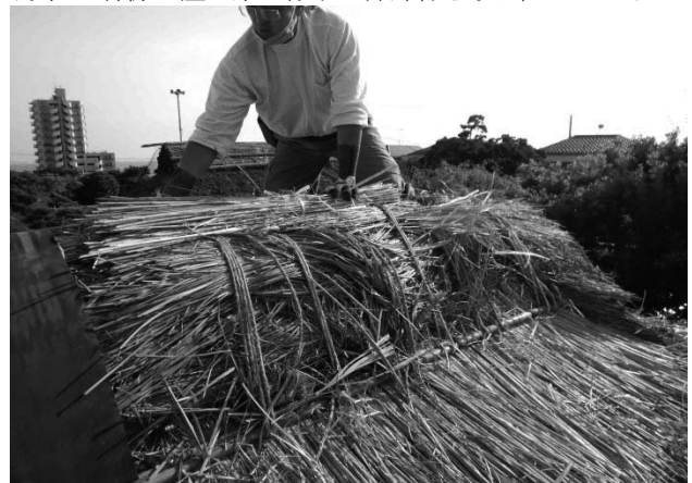
写真 62 竹簀子棟の棟積み茅調整
