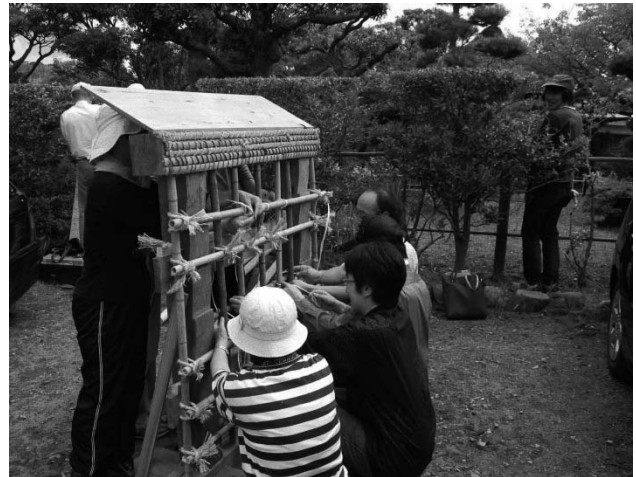
写真 122 土蔵構造模型を用い縄縛り練習(四目垣類似)
