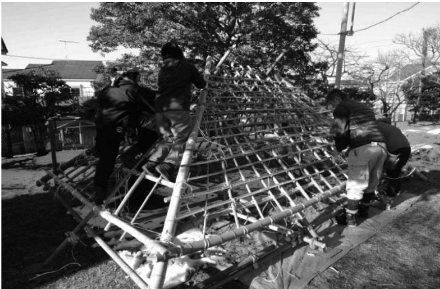
写真15 屋外模型にて寄棟造の屋根下地をつくる
