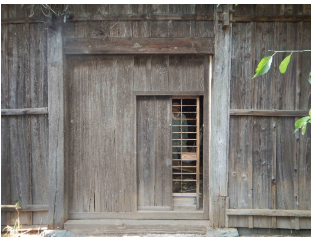
写真 大戸口および大戸修理完了
