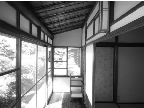
写真7 増築棟内部 南縁
