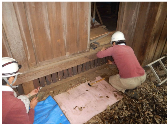
写真 新材は表面に古色塗して古材と色合いを整えた
