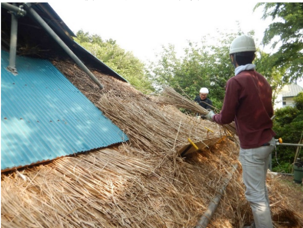
写真 固い茅を並べて押銚とる(トタン下差し込み)
