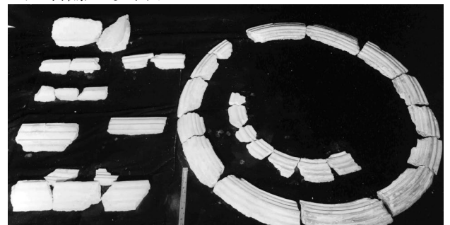
写真 2-47 旧 15 番館 1 階天井の漆喰飾り断片 空襲対策で 1 階の木造床を抜き、漆喰天井を落とした時の残骸が 地中から大量に発見された。
