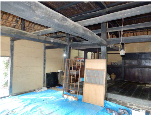
写真 荷物を戻す部分にシートを張って再収納
