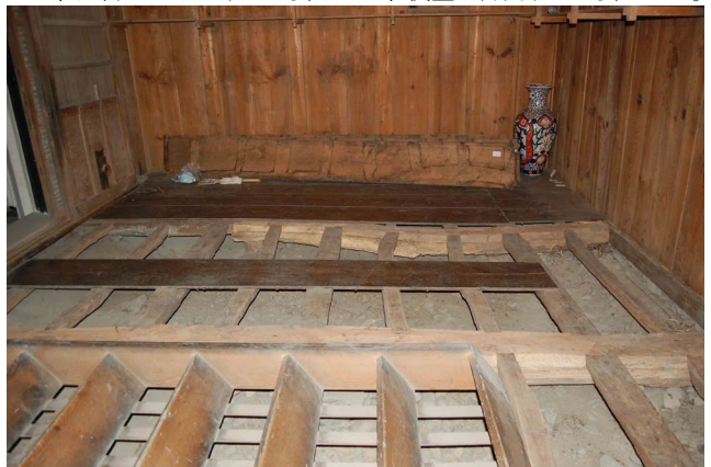
写真 2-7 同上土蔵の床板補修
