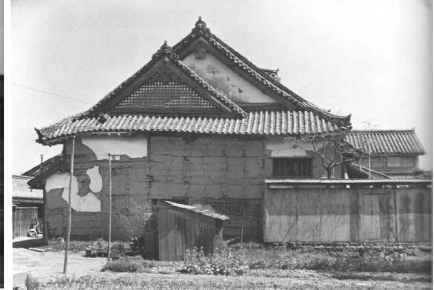
修理前西側面写真 (北丹後地震後に張出部と土蔵を撤去した)
