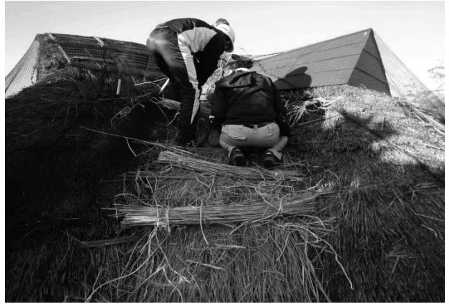
写真 50 谷を鉄板養生するために差し茅で谷を埋める
