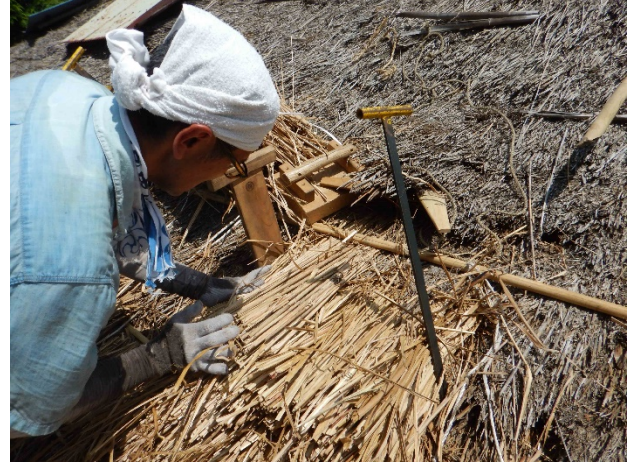
写真 押鉾下に柔らかい茅と硬い茅を差し重ねる
