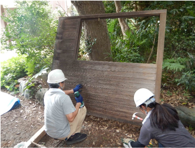
写真 大戸の修理 板の釘締め直し
