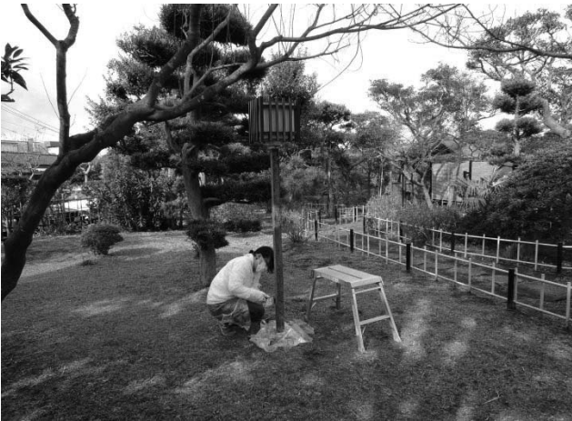
写真 127 外灯塗装ケレン
