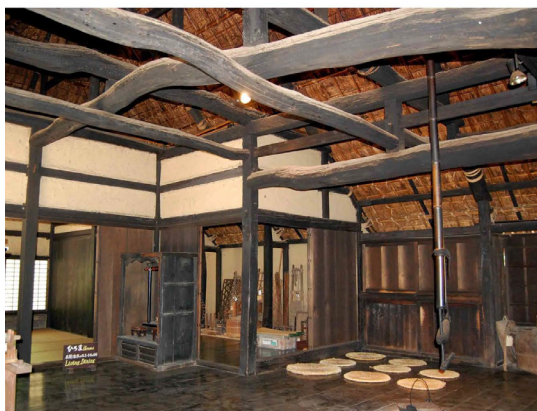
主屋棟の梁組は梁と束を組み合わせる
