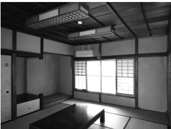
写真5 サンルーム棟内部 10畳座敷の琵琶床と肘掛窓をみる
