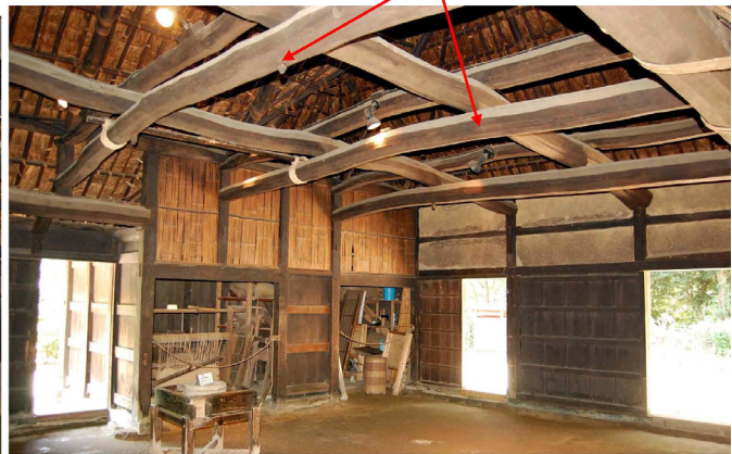
土間棟は梁を縦横3段に重ねて大柱を打ち、大空間架構を創出する
