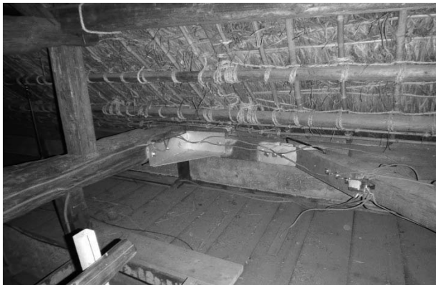
写真 103 横須賀市による書院棟小屋組応急補強状況
