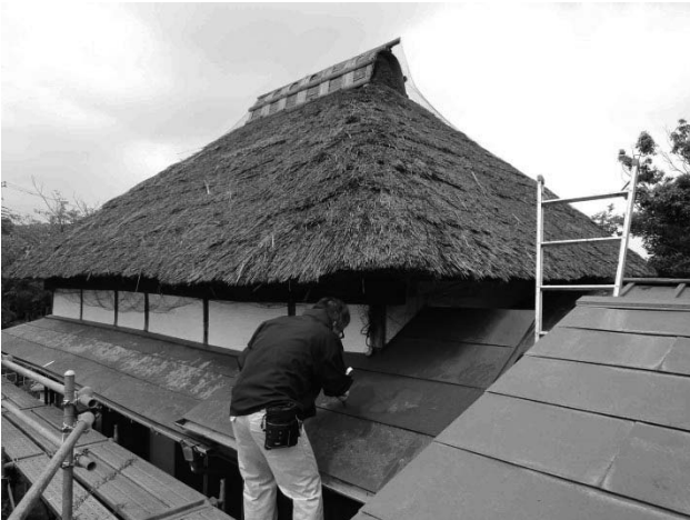
写真80 防錆塗料の下塗り（上塗り健全箇所は存置）
