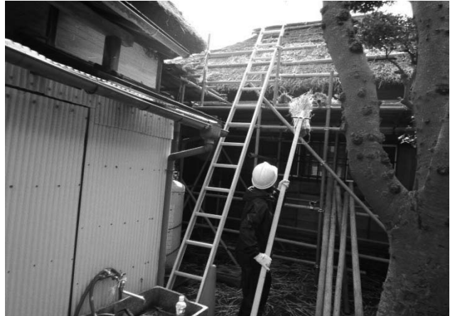
写真44 茅運び棒で足場へ上げる様子
