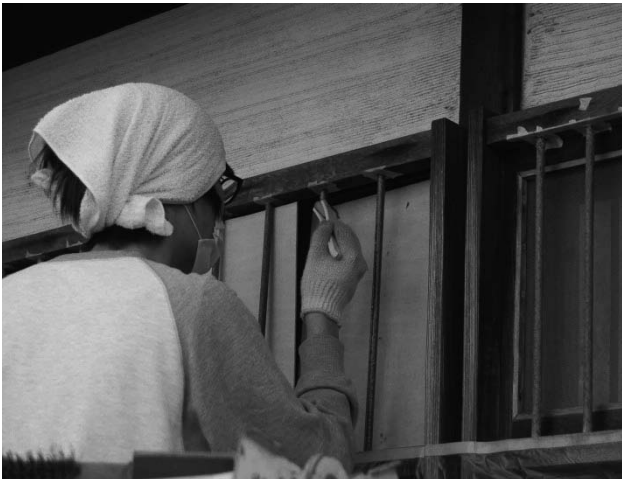
写真 119 窓鉄格子 錆止め下塗り
