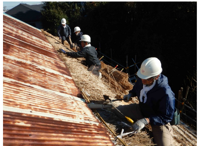
写真 トタン下の茅を引き出して上に固い茅を差す
