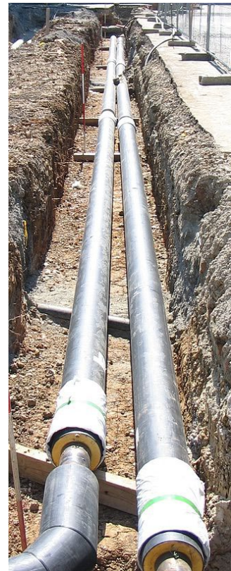
図-2.7 熱供給配管設置環境 専用トレンチ内配管 直埋設配管*
