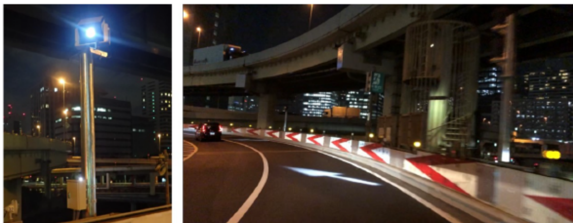
図 3-14 首都高速道路の長期試験で用いられた可変チャネルリゼーション 100)
