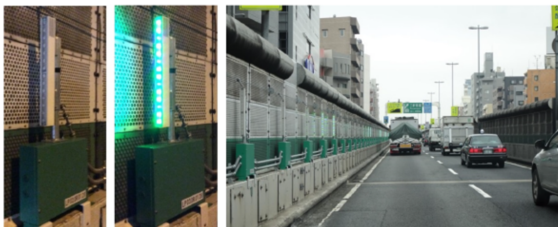
図 3-13 首都高速道路に設置されているエスコートライト 109)
