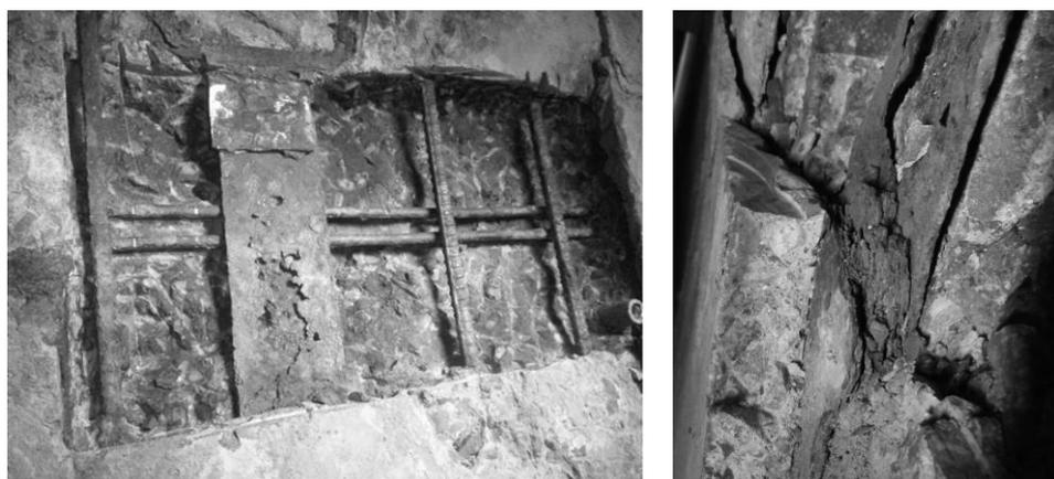
図 1-3 腐食による断面欠損
