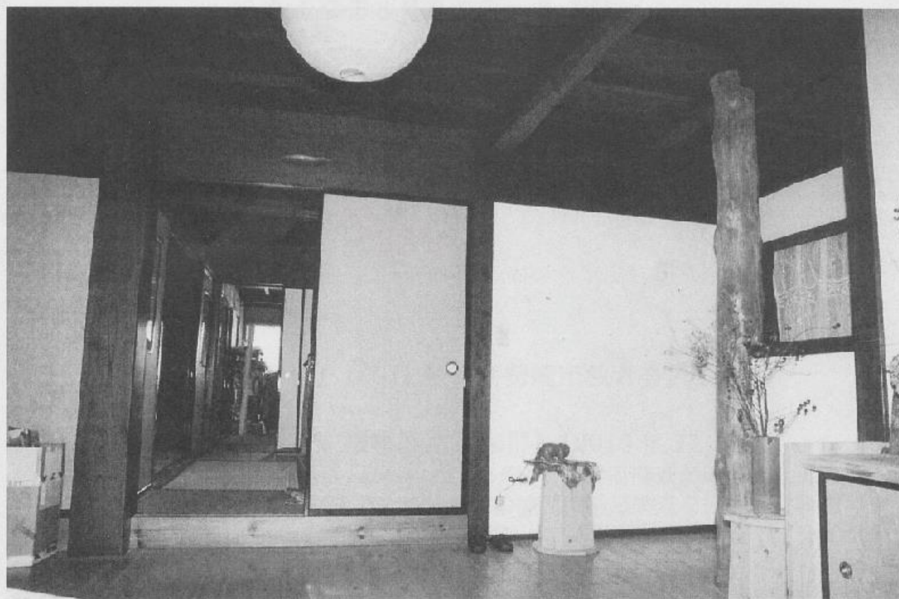
9 金井義明家 主屋 1階 上間(現板間)より下列後室を見る 20071216 石井君 DSC_0894 下列の居室境は指鴨居で2間開口であったが、中央に柱を補足して後半部を耐震壁とした。
