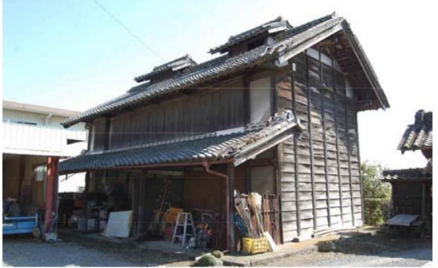
蚕室北面・西側面全景
