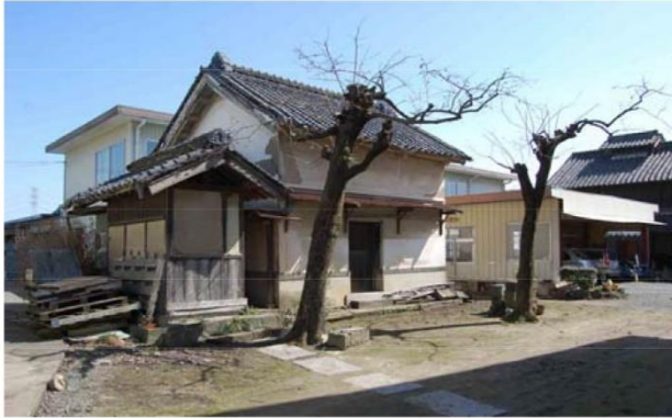
屋敷東側の外便所・穀蔵・蚕室
