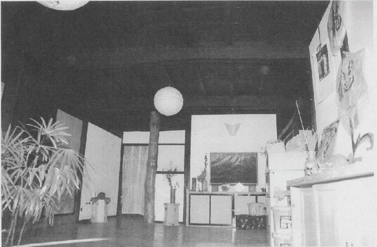
6 金井義明家 主屋 1階 上間正面出入口から後方を見る 20071216 (石井) DSC_0895 1階土間部分は手前に旧状を留めるが、後半部と東面下屋は改装して現代的な生活に適応させている。正面に見える床柱風の皮むき丸太の右手に2階への階段室を設ける。
