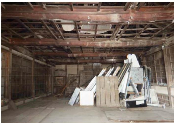
蚕室2階内部 東から西を見る
