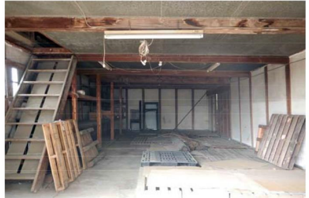
蚕室1階 東から西方を見る
