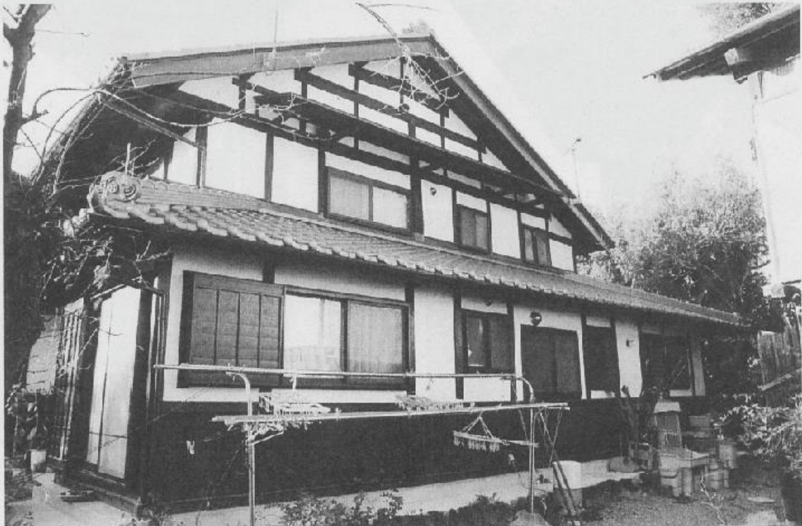
2 金井義明家 主屋 東側面 20071216 (石井) DSC_1026 写真右手に金井烏洲のアトリエだった呑山楼がみえる。
