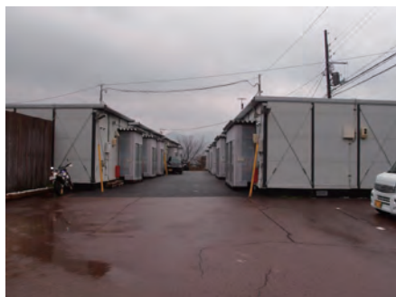
写真 3 一般的な鉄骨系プレハブの仮設住宅
