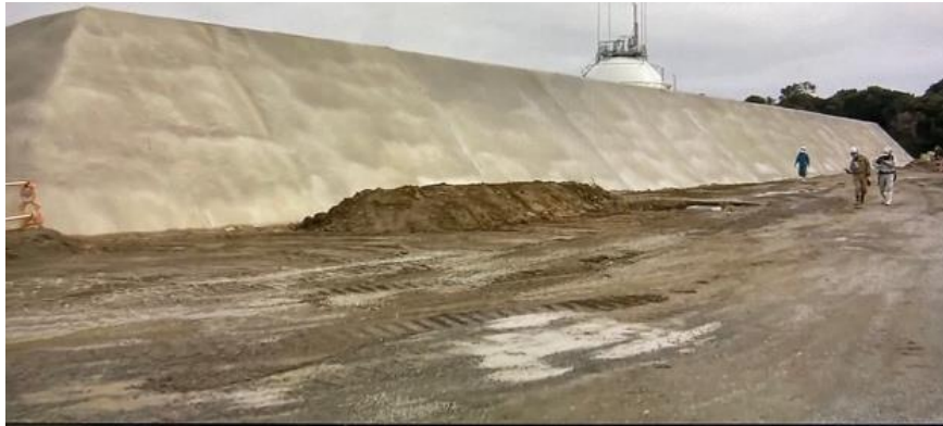
図 5.7 建設中の日向化学工場の防潮堤[24]
